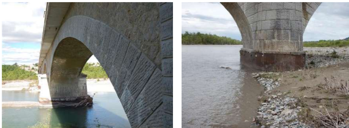
Figure 1. Illustrations de l'ouvrage et de ses appuis (photos sur site)
