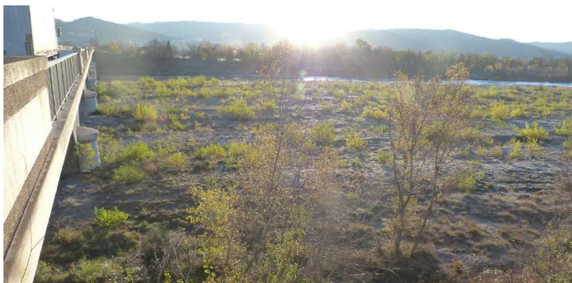
Pont d'Oraison et vue sur l'aval : bancs de galets et limons secs à Pavot Jaune et Cannier - de jeunes Peuplier noir ponctue le site. Au premier plan, derrière les arbres, la variante à Plantain toujours vert se développe en pied de berge
