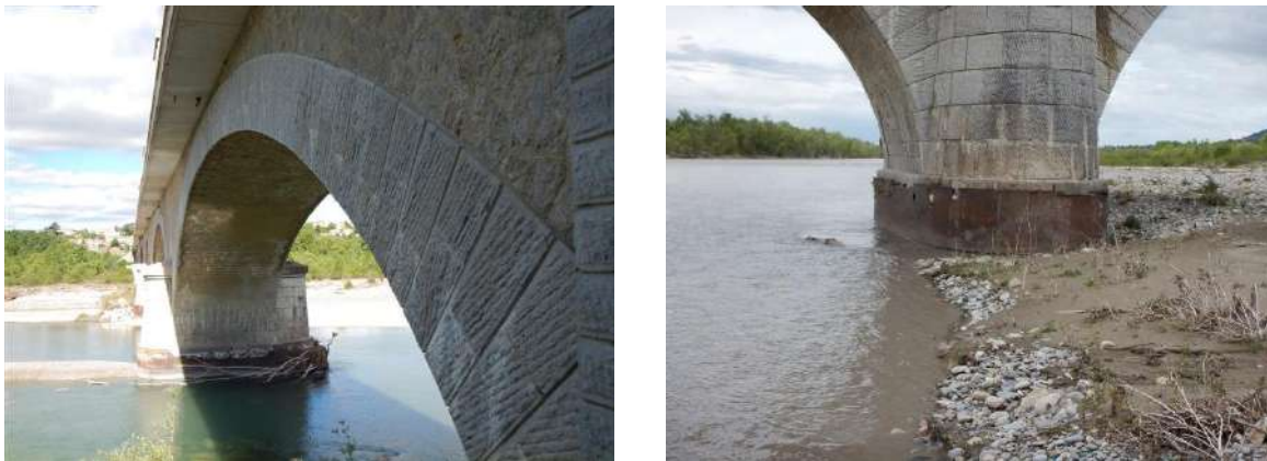
Figure 2. Illustrations de l'ouvrage et de ses appuis (photos sur site)
