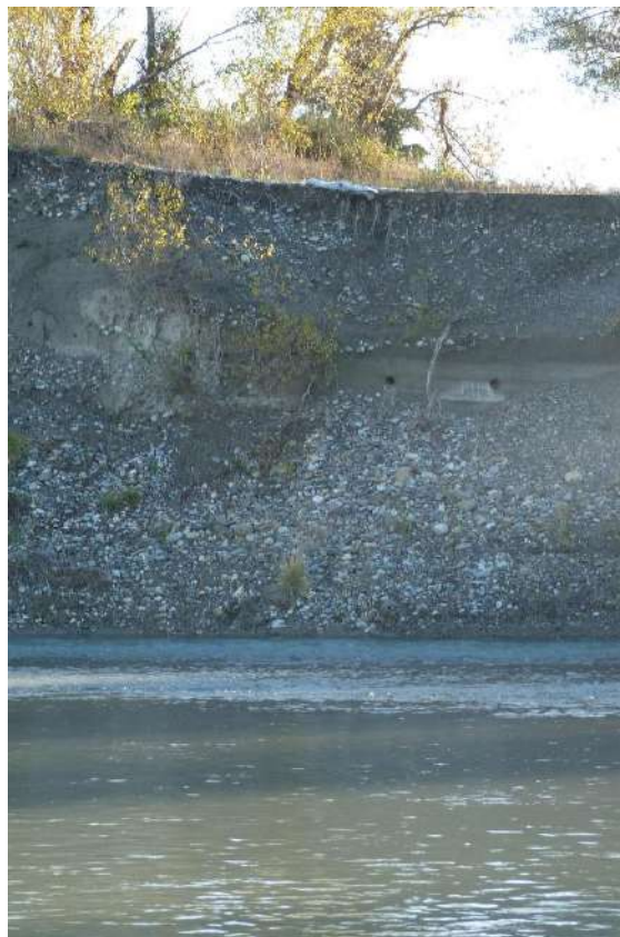
Front d'érosion sablo-graveleux de la berge
