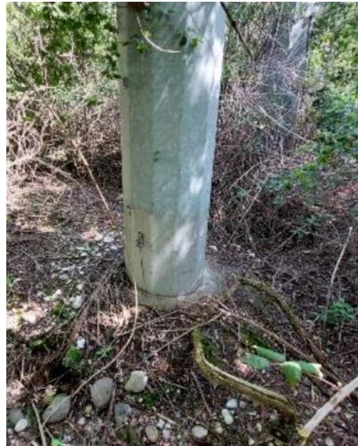
3. Pylône électrique au PR85,46 - les pieds du pylône ne semblent pas protégés contre les érosions externes – en cas d'érosion atteignant ses pieds, le pylône chuterait et entrainerait avec lui les câbles électriques sur l'autoroute (la ligne traverse l'A51 à proximité) - visite du 26 mai 2023
