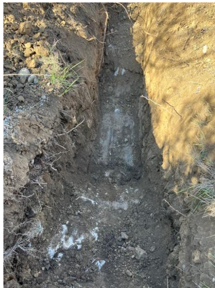
Vue du fond de fouille
