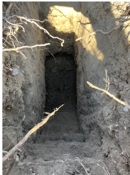
Vue du fond de fouille
