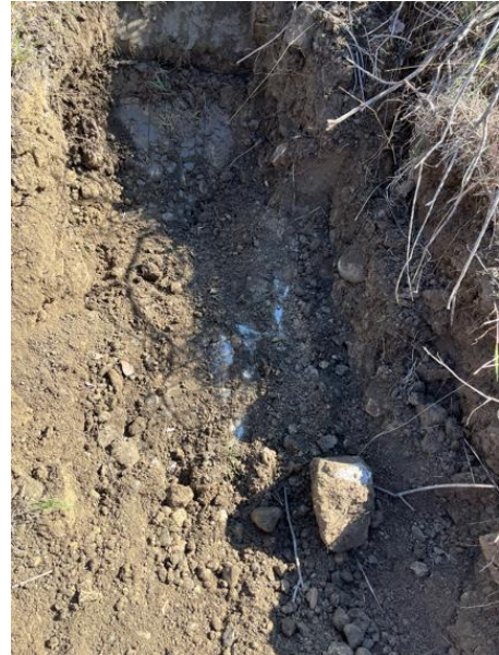
Vue du fond de fouille
