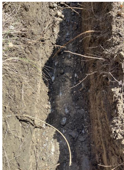
Vue du fond de fouille
