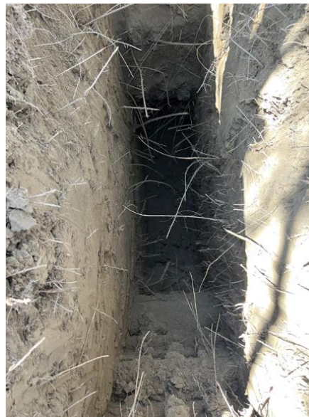
Vue du fond de fouille
