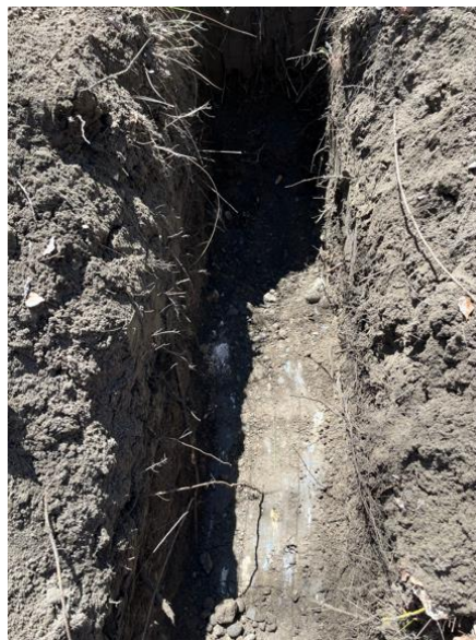
Vue du fond de fouille
