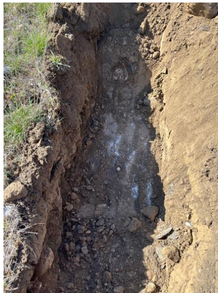
Vue du fond de fouille
