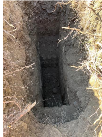
Vue du fond de fouille
