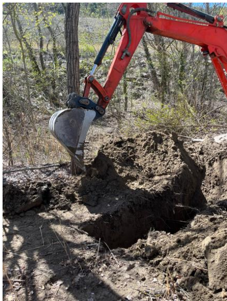
Vue générale de la fouille
