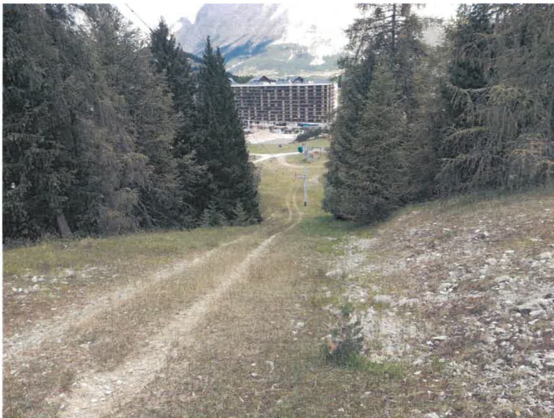
Photo 4 Vue vers l'aval, dans le layon du télésiégi de La Roche, en limite Est de la ligne de remontée du projet de luge
