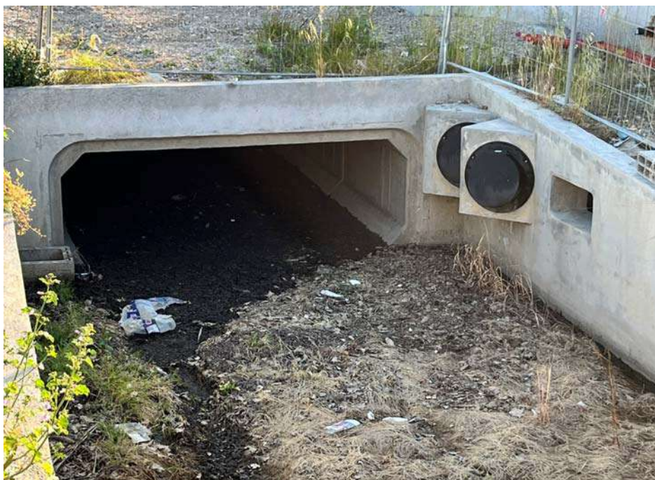
FIGURE 7 : EXUTOIRE REALISE EN AMONT DE LA RD6007
