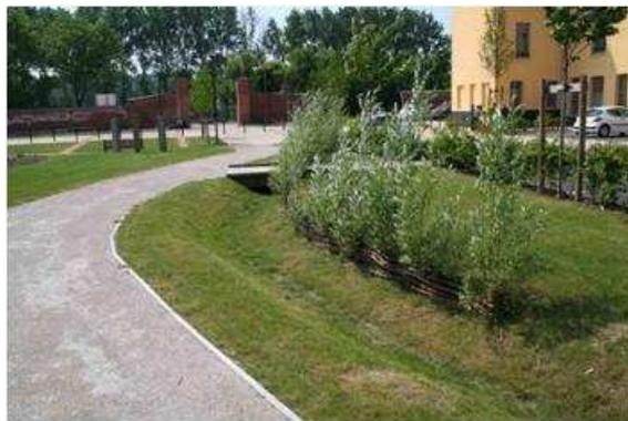
*Noue de stockage et d'infiltration sur le parking de la gare à Yvetot (76)*
