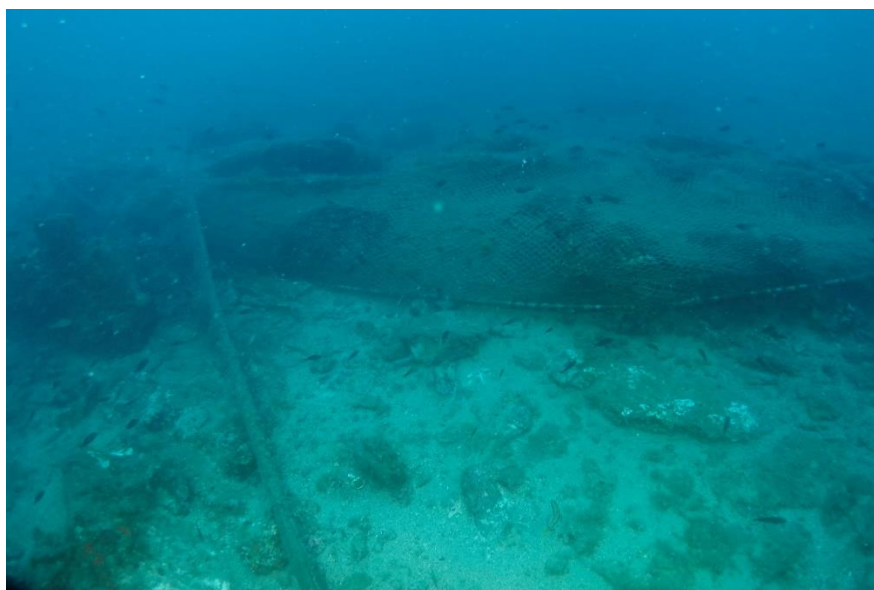
Figure 63 : Câble colonisé par les algues encroûtantes à proximité du filet de pêche et de l’affleurement rocheux
