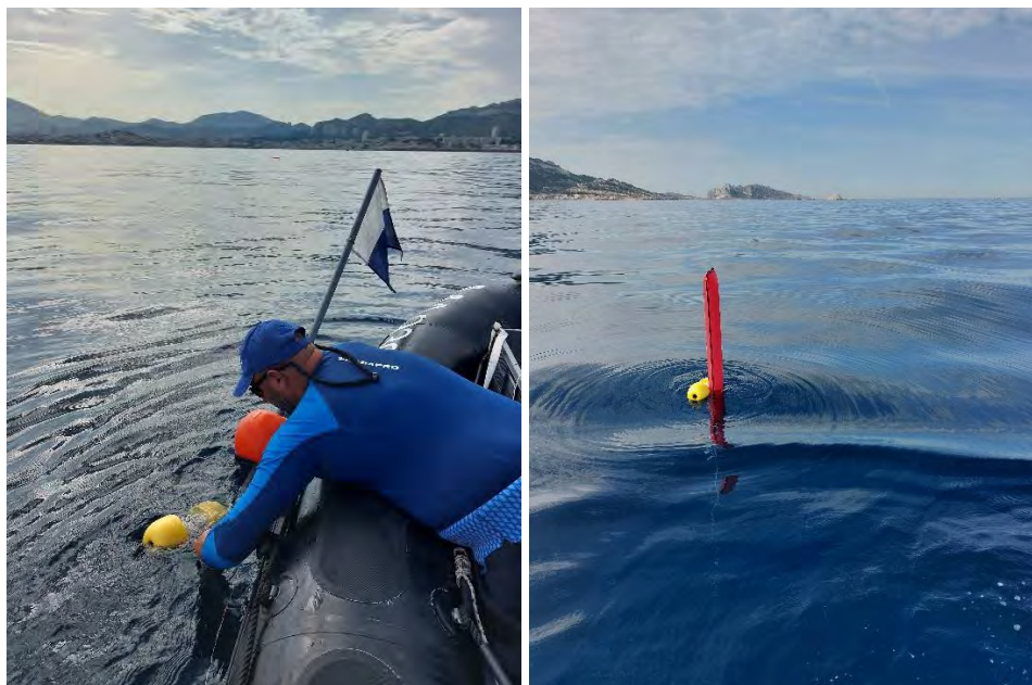
Figure 8 : Installation des balises le long du tracé du câble
