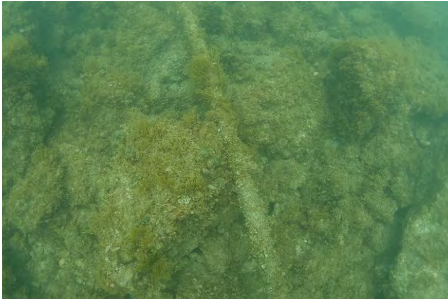
Figure 74 : Câble télécom sur des enrochements (Marseille, 2020)
