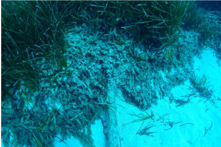
Figure 75 : Câble transport d'énergie pris dans la matte de posidonie (Bonifacio, 2020)
