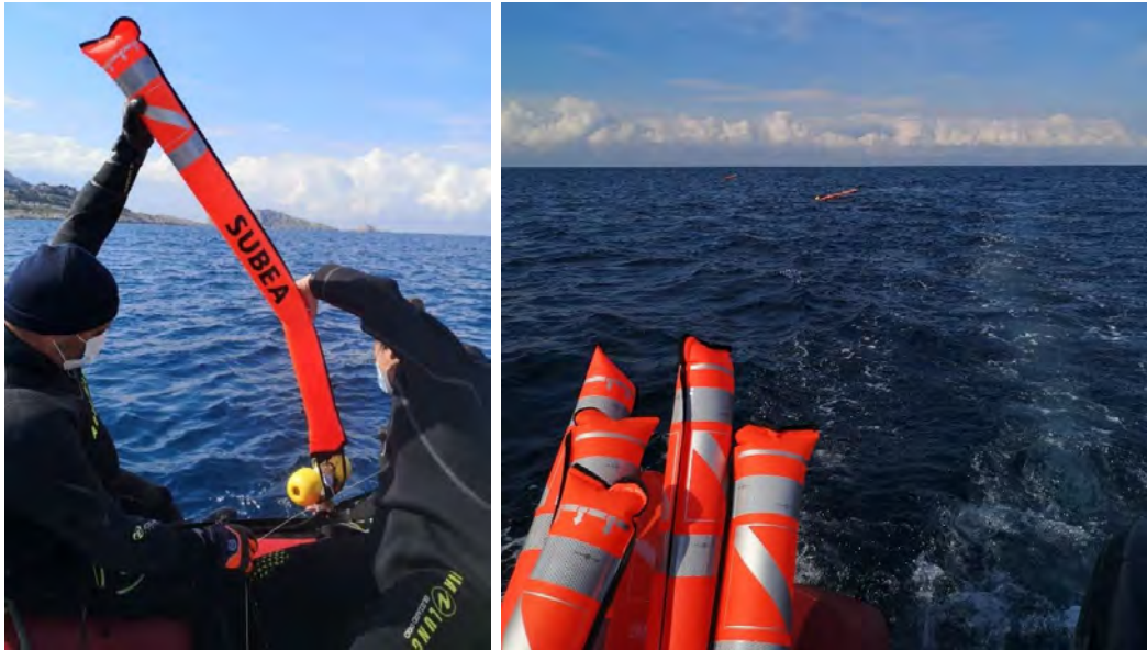
Figure 7 : Installation des balises le long du tracé des câbles
