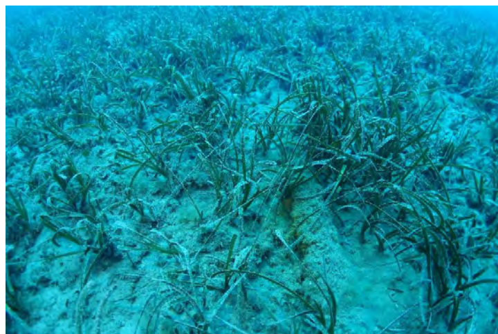
Figure 80 : Câble de transport d'énergie (SACOI2) en limite inférieure de l'herbier de posidonie et disparaissant dans la matte (Bastia - plage de l'Arinella, 2020)
