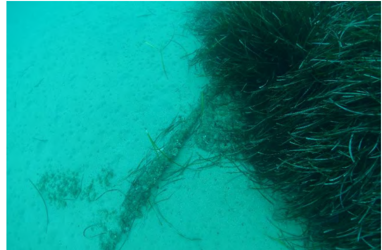
Figure 83 : Câble télécom en sortie d'herbier en limite supérieure (Marseille, 2020)
