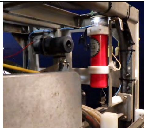
Figure 41 - Transpondeur sur cage (source : SAAS)
