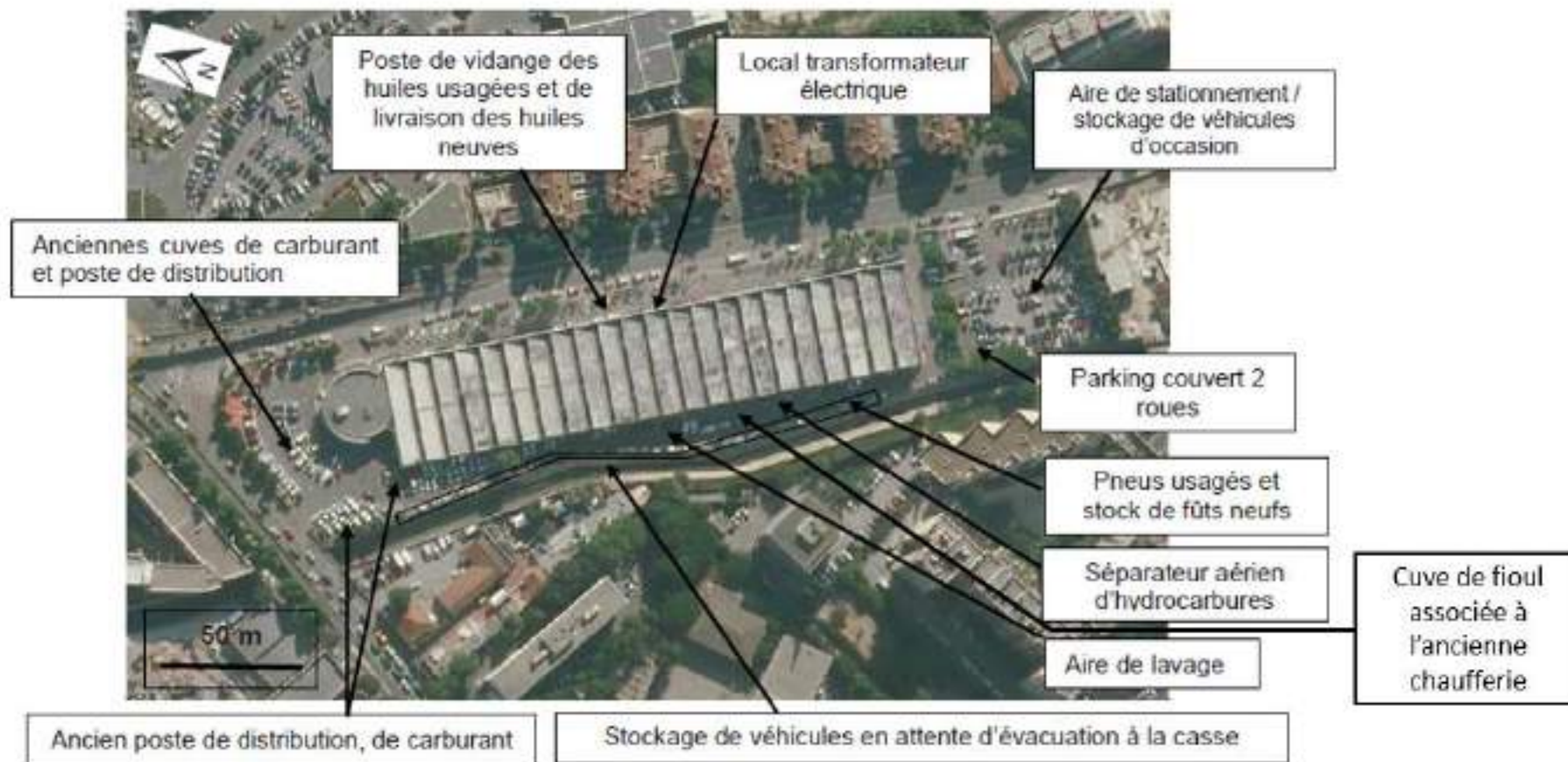
Figure 4 : Installations à l'extérieur (Source : rapport ICF AIX15 054 IB_PSA_MRA-Rabatau-V1)
