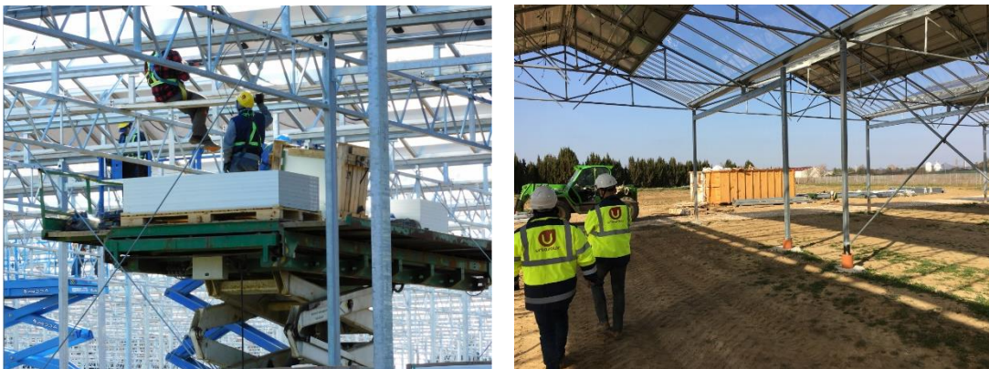
Figure 2. Photographies du montage des structures
