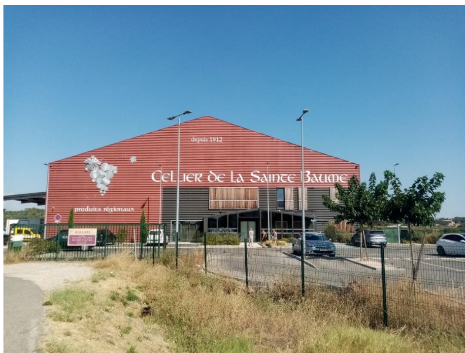
Figure 4 : Cave coopérative "Cellier de La Sainte Baume"
