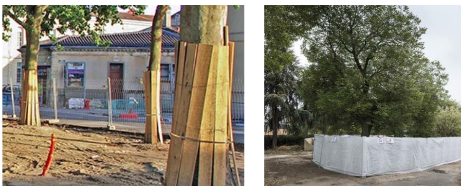
Figure 23. Exemple de mesures de protection des individus arborés conservés
