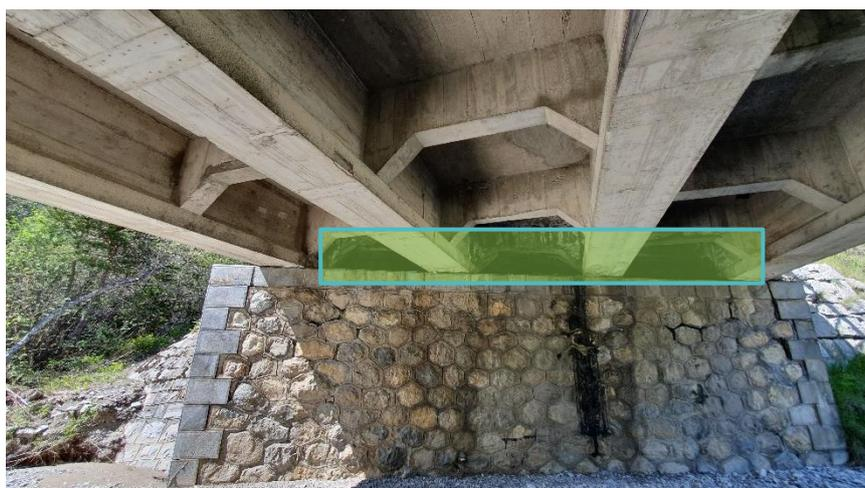
Figure 4 – Espace favorable entre le tablier et la culée du pont (rive gauche)
