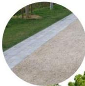
Bordure béton arasée pour les chaussées en zone 30 en enrobé granulaire
