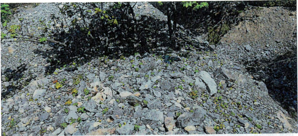
↑ Vue rapprochée— zone aval - PHOTO 22 ↑
