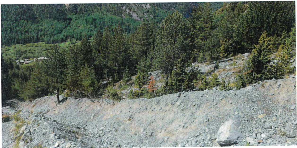
↑ Vue rapprochée— zone amont - PHOTO 12 ↑
