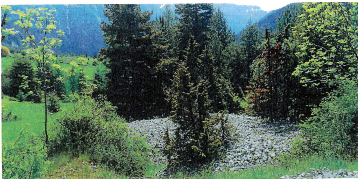
↑ Vue rapprochée– zone aval - PHOTO 28 ↑
