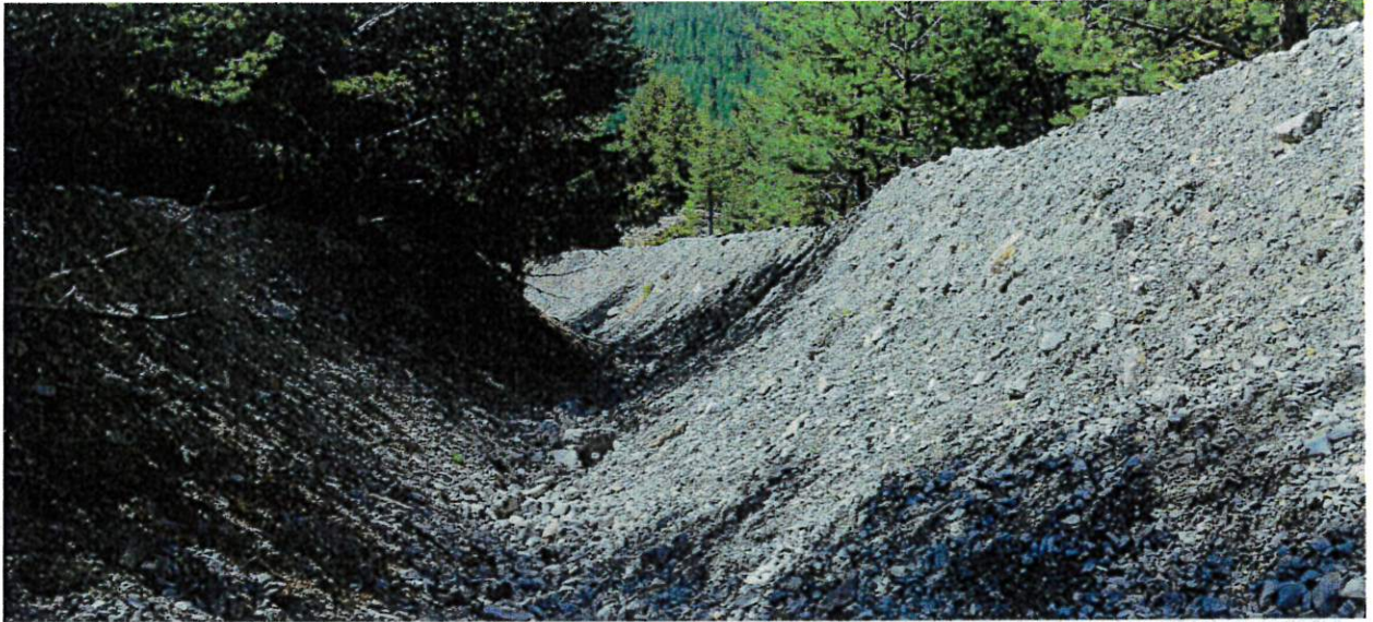
↑ Vue rapprochée- zone aval - PHOTO 19 ↑
