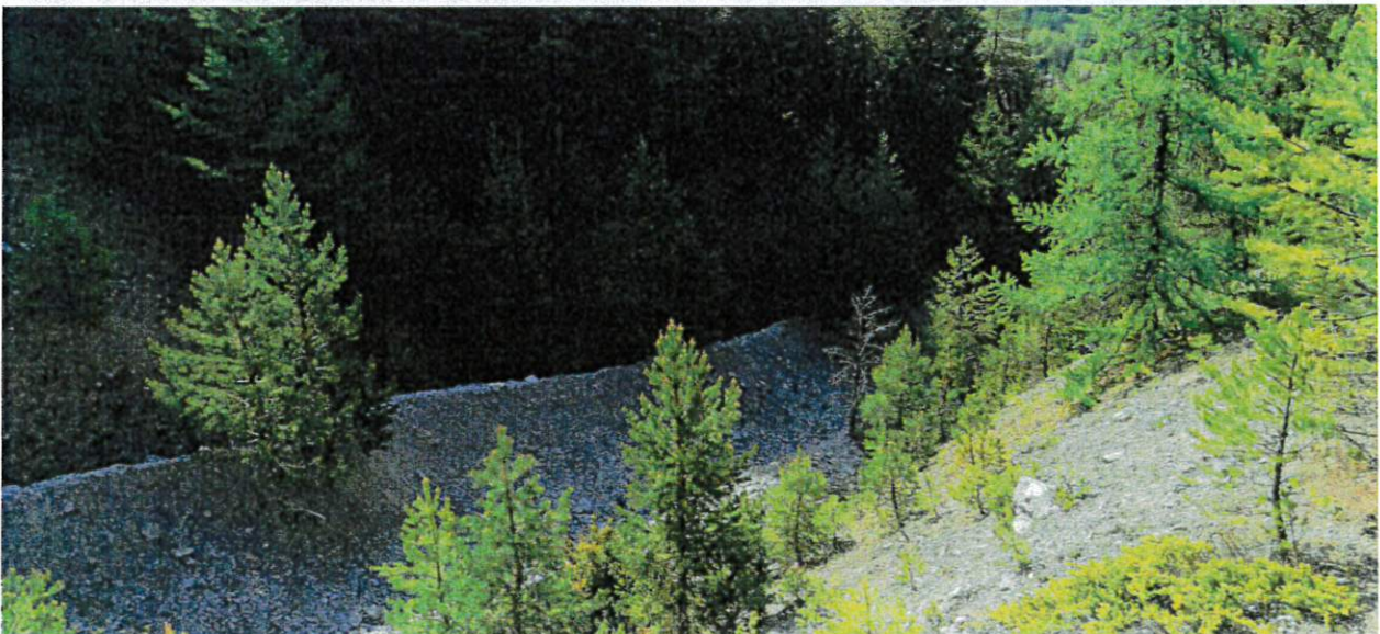
↑ Vue rapprochée-- zone aval - PHOTO 15 ↑
