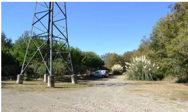
Zone rudérale au niveau du parking et aperçu d'un pylône de la ligne électrique
