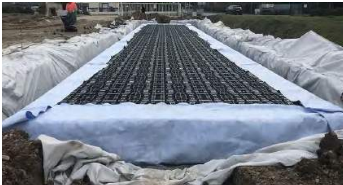
Figure 12 : Exemple de mise en place d'un Aquatextile oléo-dépolluant TenCate GeoClean® Origin
