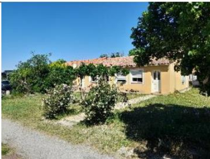
Maison d'habitation de la famille MEKCHOUCHE – vue vers le Nord-ouest
