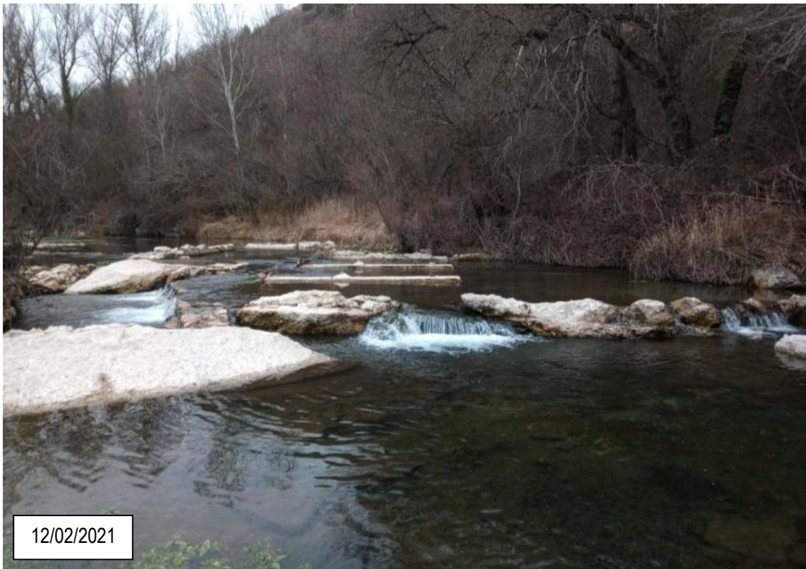
Figure 7 : Radier béton à supprimer (vue depuis l'aval)
