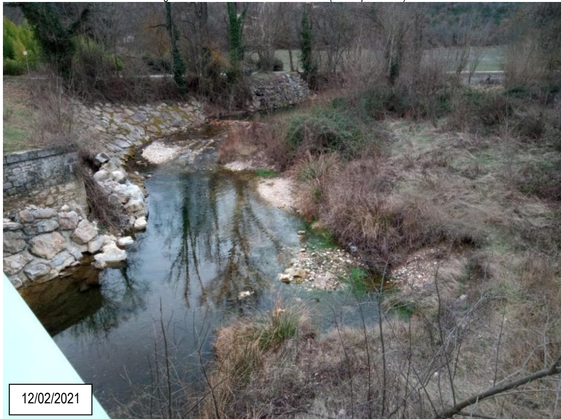
Figure 24 : Berge à reculer en rive gauche + génie végétal (vue depuis l'aval) + protections de berge à conforter en rive droite
