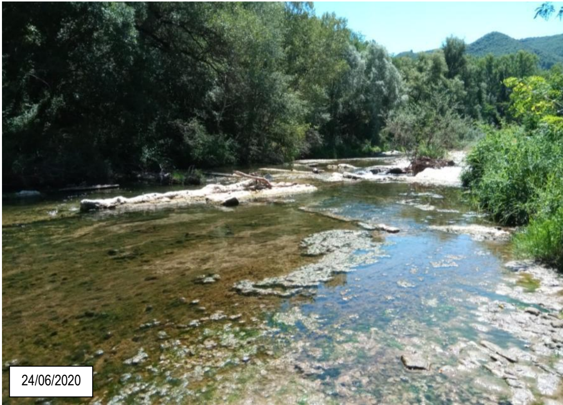
Figure 6 : Vue d'ensemble de l'ancienne prise d'eau (vue depuis l'amont)
