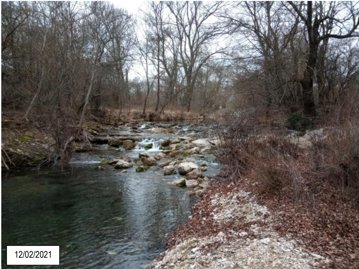
Figure 29 : Seuil à effacer (vue depuis l'aval)
