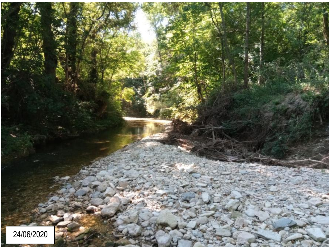
Figure 32 : Coude à élargir (vue depuis l'amont)
