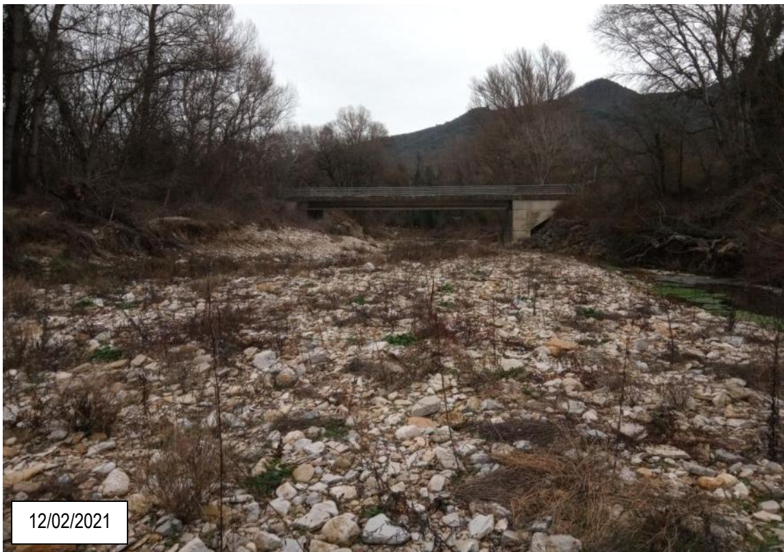
Figure 8 : Vue d'ensemble de l'action 2 depuis l'amont
