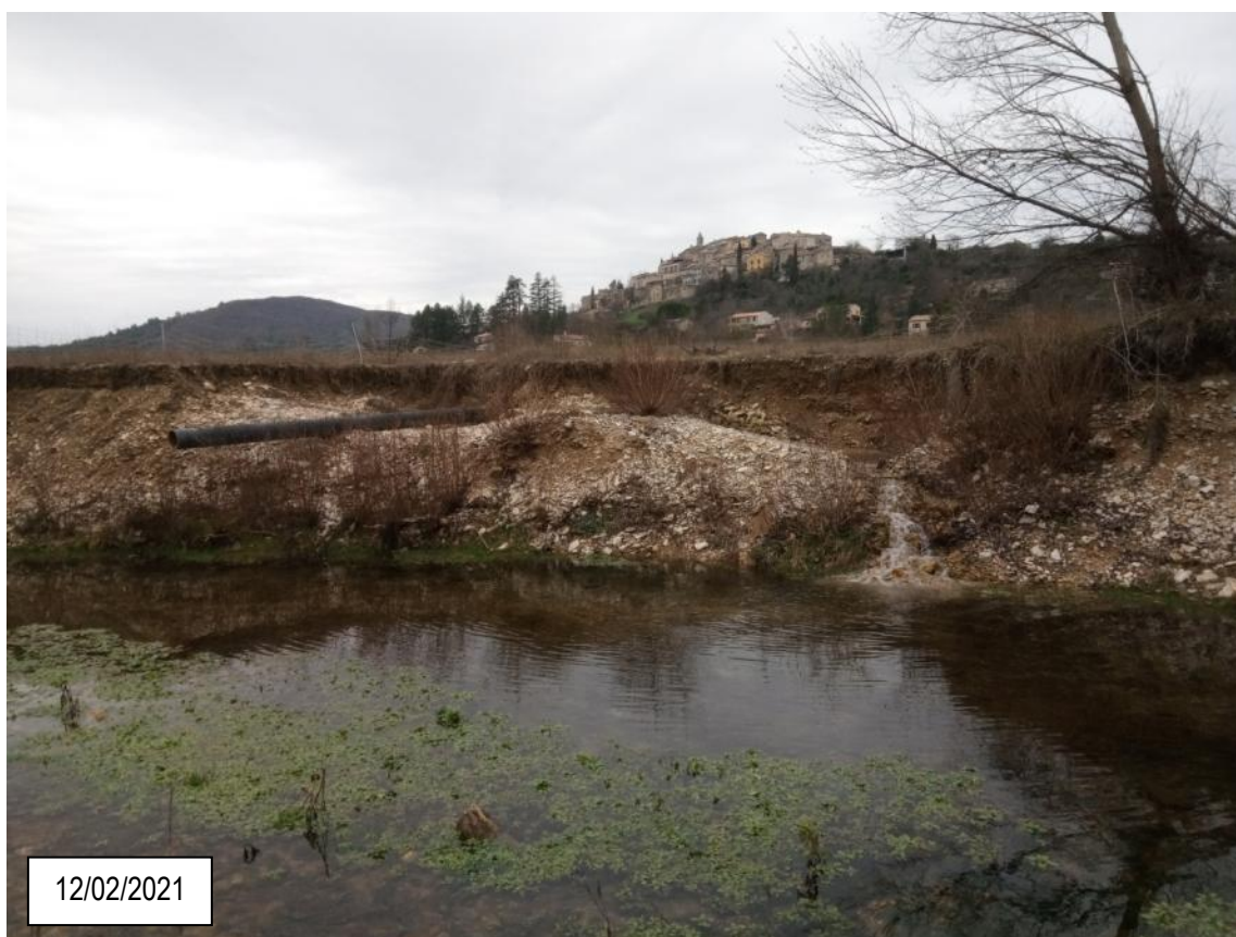
Figure 21 : Aval de la protection de berge en génie végétal en rive droite
