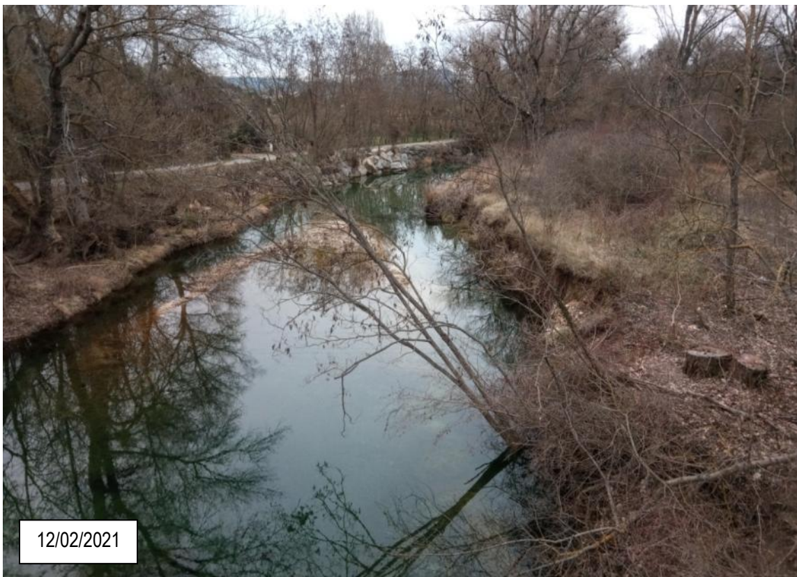
Figure 28 : Berge à conforter en rive gauche, et berge à reculer + génie végétale en rive droite (vue depuis l'amont)
