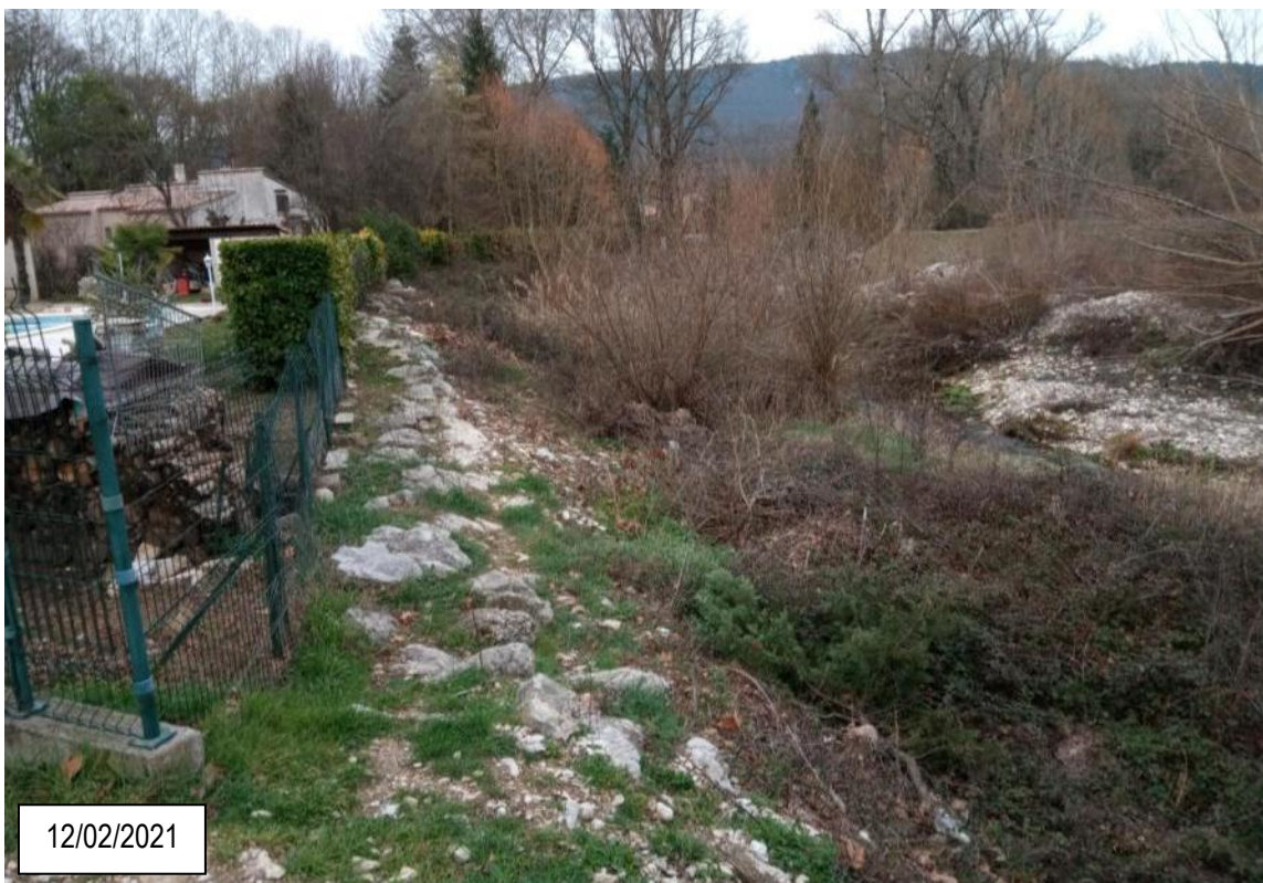
Figure 18 : Vue d'ensemble de l'action 2 du secteur 2 (depuis l'amont)
