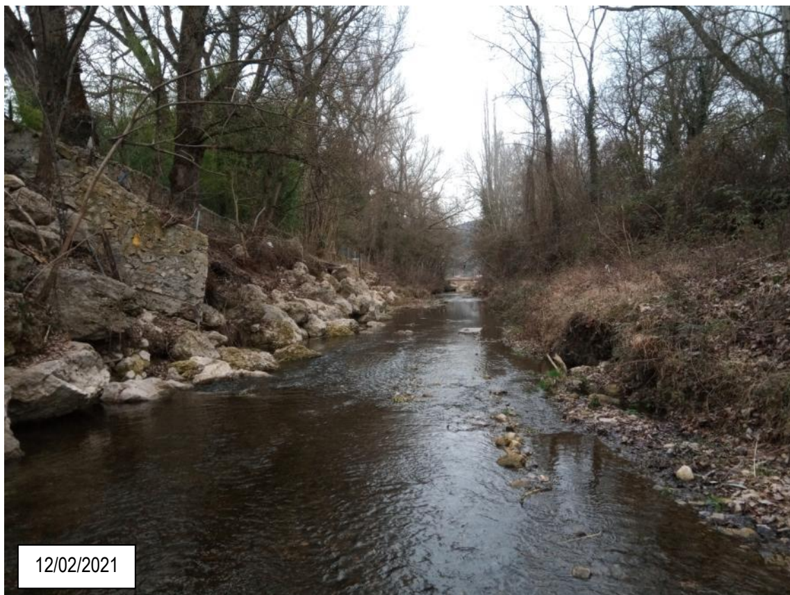
Figure 20 : Protection de berge à conforter en rive gauche et élargissement du lit + génie végétal en rive droite (vue depuis l'amont)
