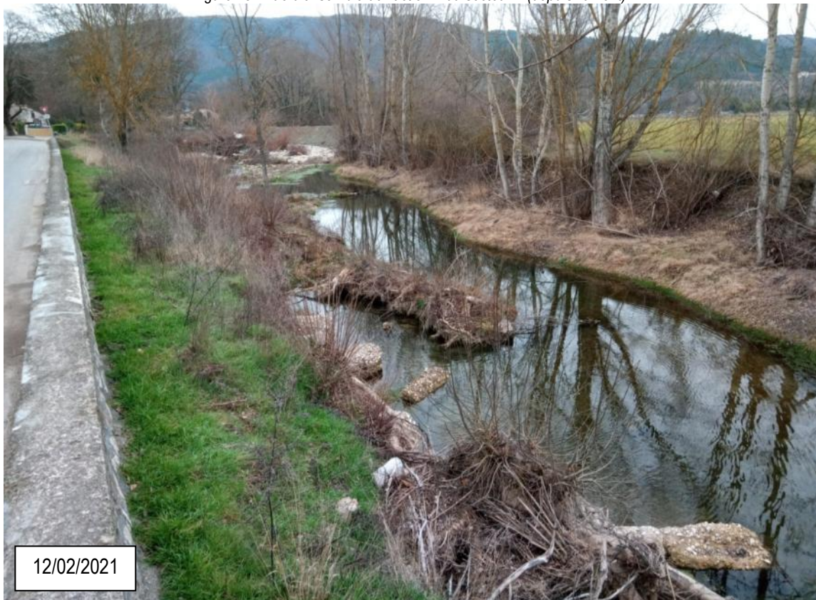
Figure 16 : Berge à reculer en rive droite + génie végétale (vue depuis l'amont)
