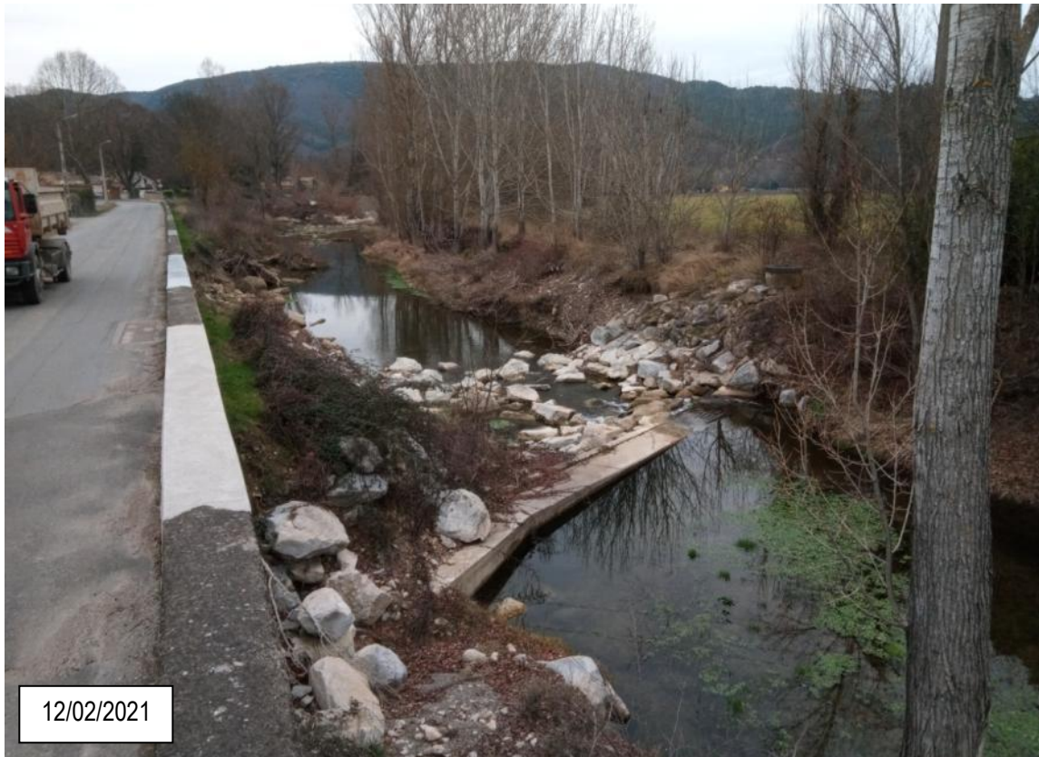
Figure 15 : Vue d'ensemble de l'action 1 du secteur 2 (depuis l'amont)
