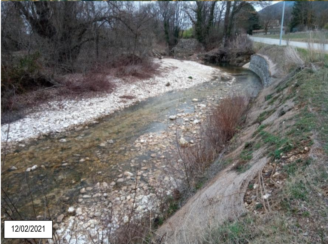
Figure 26 : Berge à conforter en rive droite et atterrissement à supprimer en rive gauche + élargissement du lit (vue depuis l'amont)
