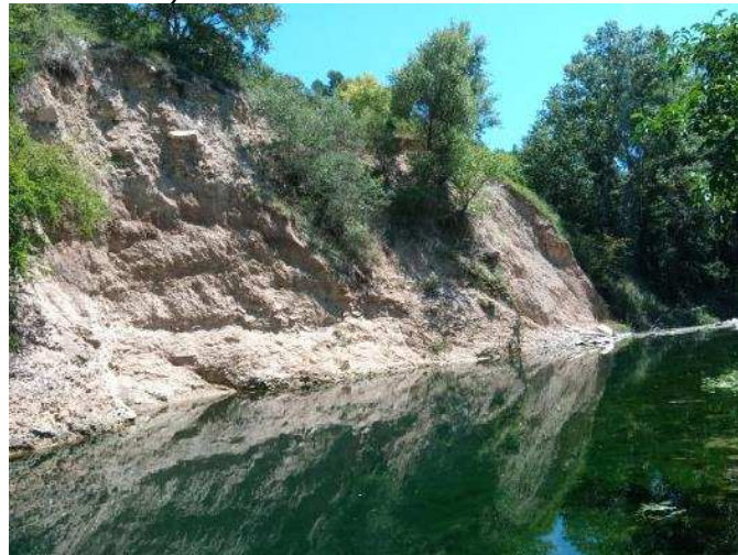
Figure 3 : Anse d'érosion en amont du secteur.
