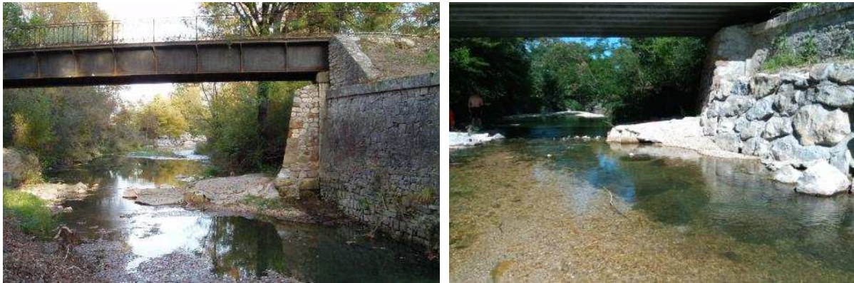
Figure 82 : Photo du pont et de la culée rive droite en 2009 à gauche (IPSEAU, 2009) et en 2019, à droite.
