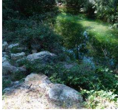
Figure 24 : Vue des enrochements sur la berge en rive gauche.
