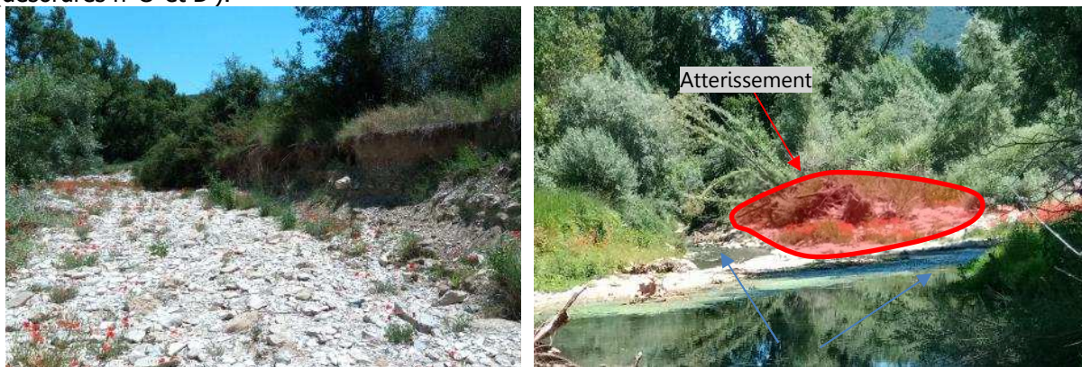
Figure 15 : Vue de la berge érodée en rive droite (gauche) et de l'atterrissement (droite).
