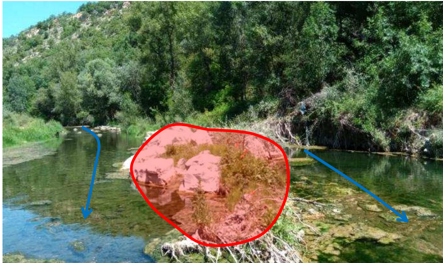
Figure 7 : Ancienne protection de berge contournée, vue depuis l'aval.
