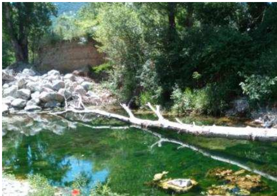
Figure 4 : Protection de berge en rive droite. A gauche, on visualise le début de contournement par l'amont et à droite le secteur érodé à l'aval avec des blocs désorganisés en pied.
