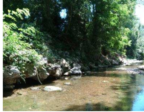
Figure 16 : Protections de berges en mauvais état en rive gauche.
