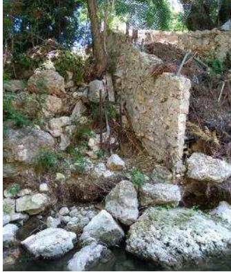
Figure 16 : Protections de berges en mauvais état en rive gauche.
