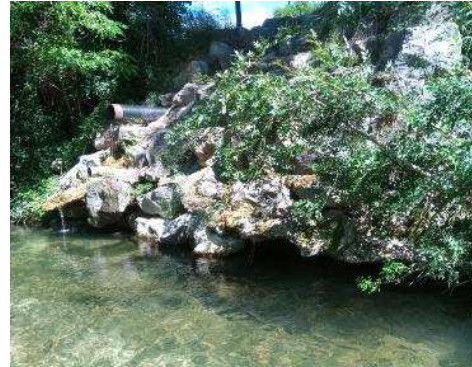
Figure 22 : Vue des enrochements bétonnés en mauvais état à l'amont du pont rouge.
