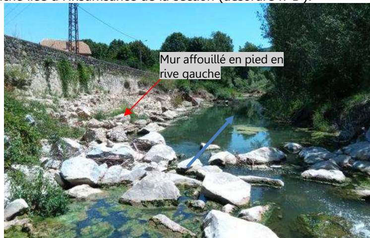
Figure 14 : Erosion de la berge rive gauche à l'aval du seuil.
