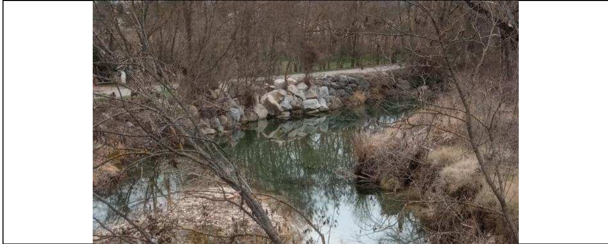
Figure 102 : Coupe type du confortement sur le secteur érodé à l'aval du pont (PT n°34). Etat actuel (dessous).
