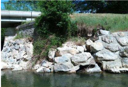
Figure 22 : Vue des enrochements bétonnés en mauvais état à l'amont du pont rouge.
