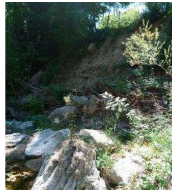
Figure 4 : Protection de berge en rive droite. A gauche, on visualise le début de contournement par l'amont et à droite le secteur érodé à l'aval avec des blocs désorganisés en pied.
