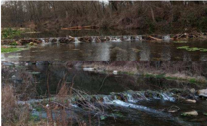
Figure 10 : Vue du seuil de castor amont (dessus) et aval (dessous).
