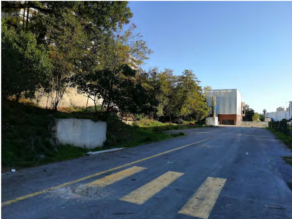
Figure 6 : Zone en enrobé en partie sud
