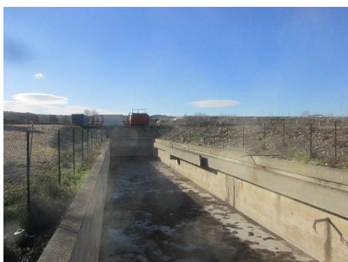
Bassin qui sera démoli
