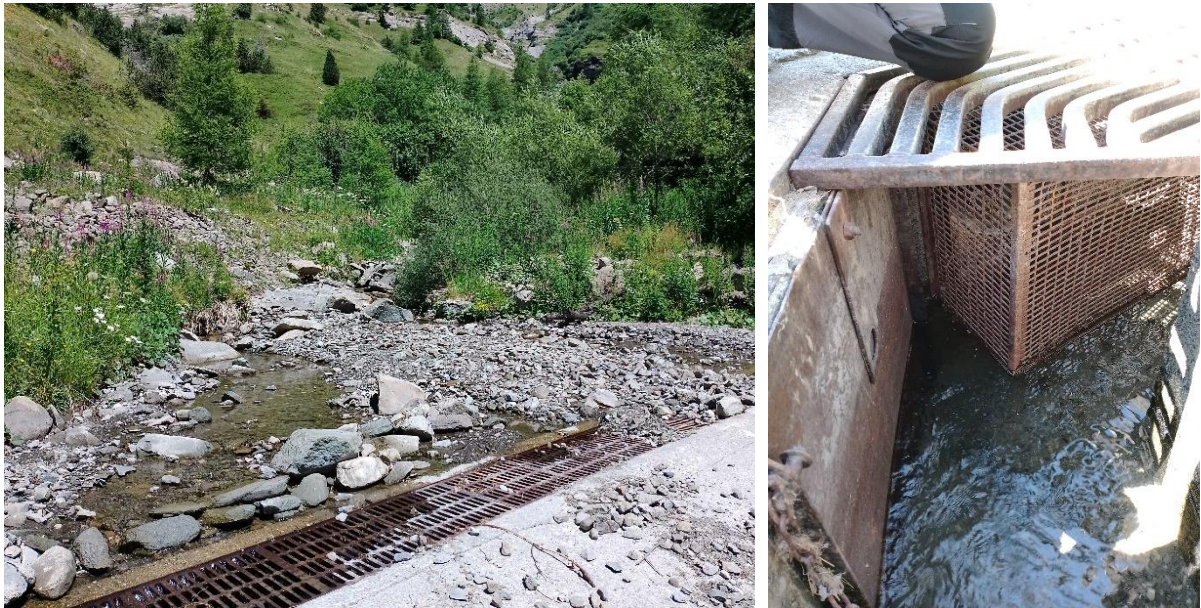
Figure 8 : prise d'eau (dite prise amont) de la retenue du Sellaret sur la partie amont du torrent de Buissard composé d'un ouvrage de type seuil béton et d'une cunette transversale. Le débit réservé de 5 l/s est assuré par une plaque percée (à gauche sur la photo de droite).
