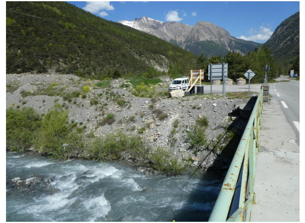
Photo 3 – Berge droite aval depuis le pont des Gleizolles- 2023
