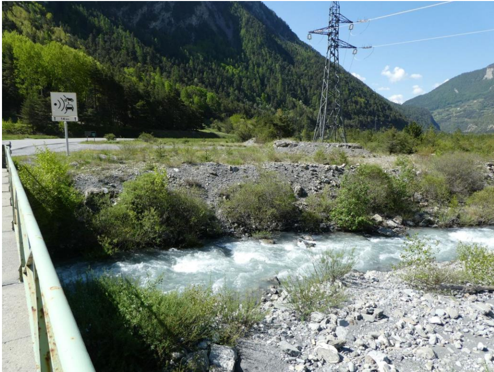
Photo 4 – Berge gauche aval depuis le pont des Gleizolles - 2023
