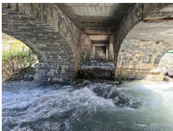
Sous face ouvrage – accueil chiroptères restreint – CD04-2023
