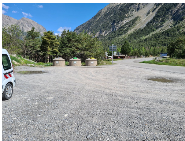
Berge droite aval – Aire de dépôt de tri – CD04-2023
