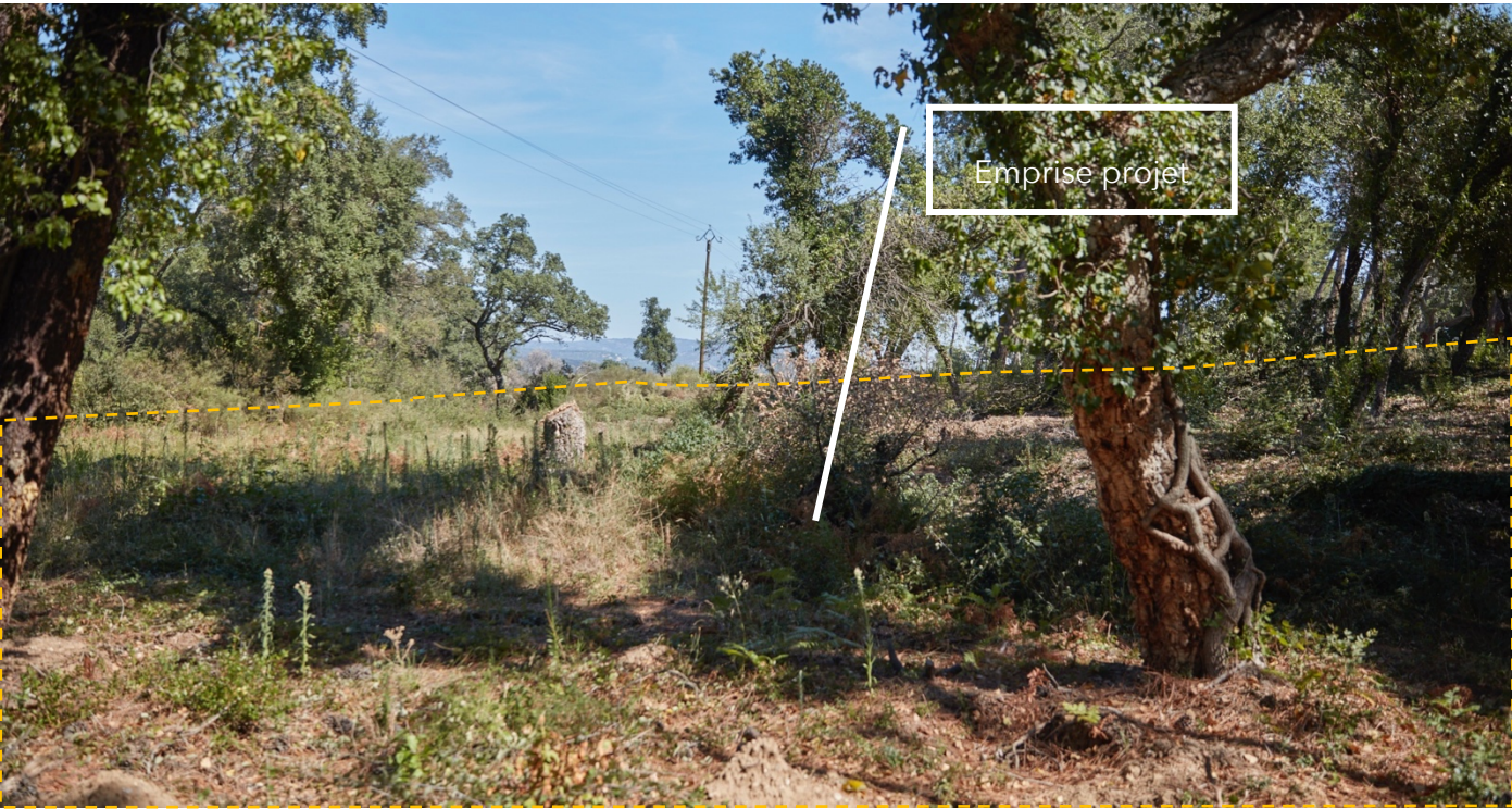
Photographie 13 : sur la ligne électrique, vers l'est
