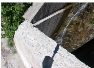
Reprise des arases avec + 7 cm minimum Passivation si nécessaire
