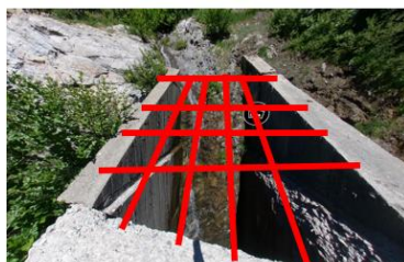
Mise en place d'un râtelier à 30° dans le sens de la pente
