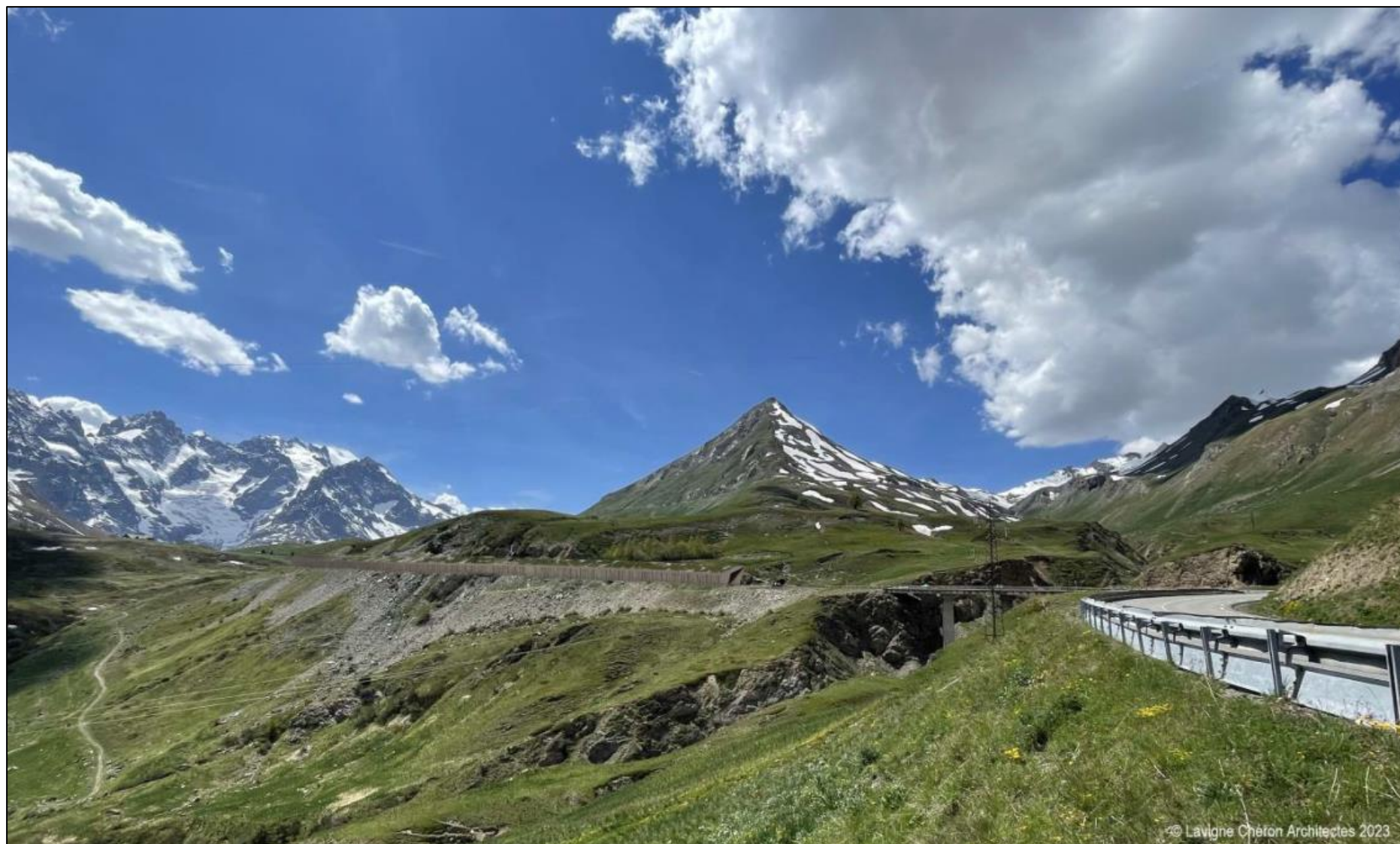
Figure 20 : Vue lointaine du projet depuis la RD1091 (source : Lavigne Chéron Architectes)
