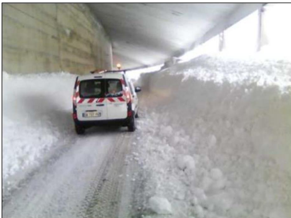
Figure 16 : Conditions d'exploitation de la galerie de la Marionnaise existante dans des conditions hivernales extrêmes
