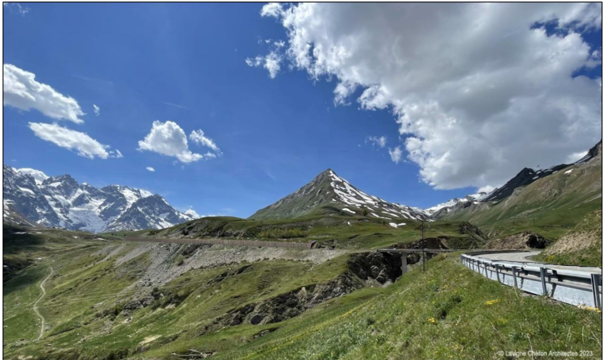
Figure 33 : Vue éloignée sur la future galerie de la Marionnaise
