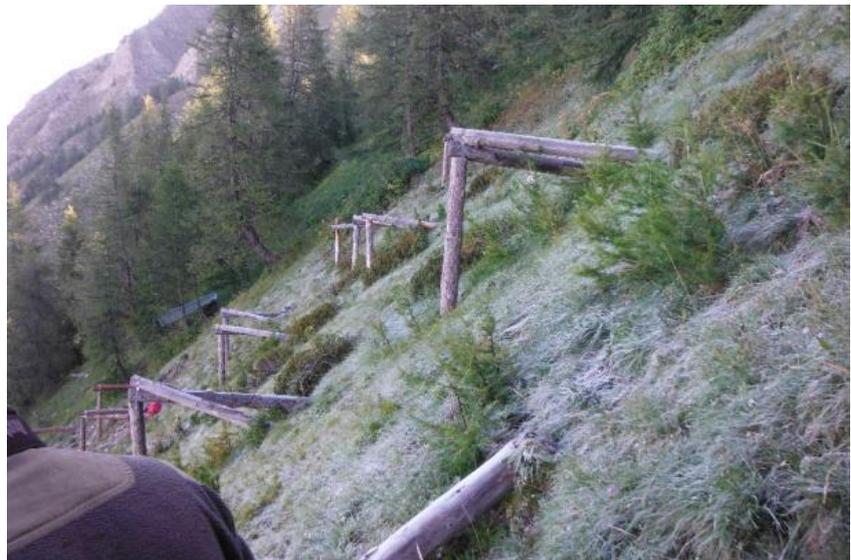
**Figure 14** : Principe de boissements paravalanches. Source étude ONF-RTM 2019
