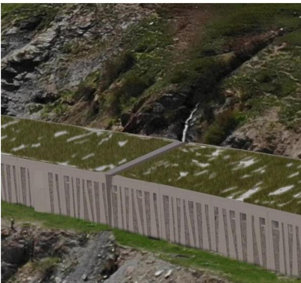
On notera aussi le rétablissement du thalweg et du petit écoulement hydraulique. Afin d'éviter des circulations d'eau à l'arrière de la galerie nous avons installé un caniveau sur la toiture. L'exutoire se fait ensuite par une rainure le long du mur aval, rainure qui viendra s'intégrer facilement dans les éléments architecturés voisins.
