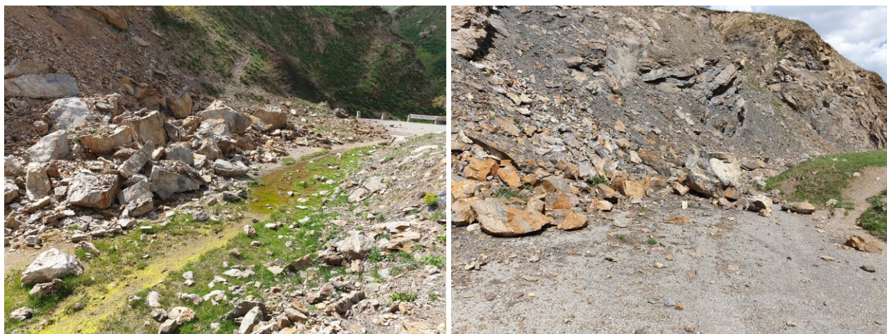
Figure 8 : État actuel de la piste de déviation du pont de Roche Noire
