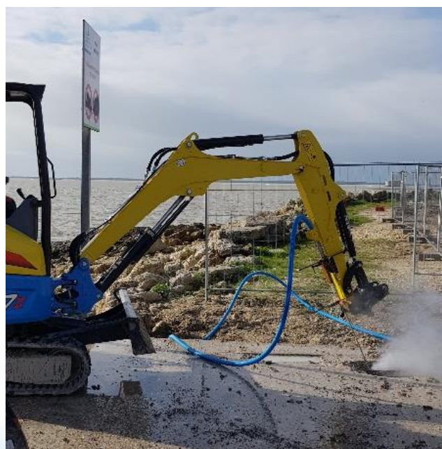
Figure 17 : Exemple de poste d'hydrodémolition
