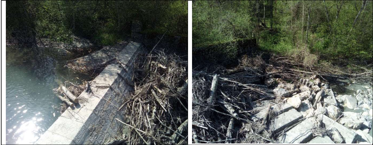
Figure 3 : Dépôts de bois en aval immédiat du barrage
