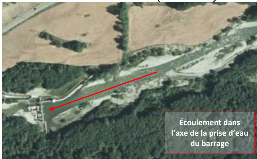
Figure 2 : Situation actuelle et souhaitée après travaux
