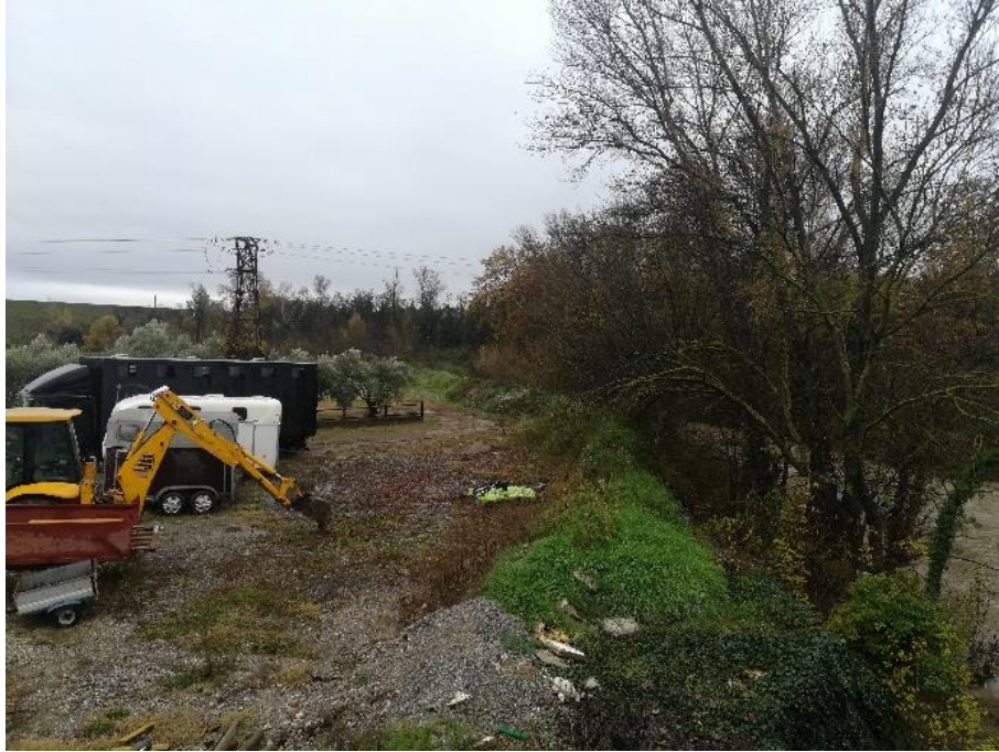
Figure 11 : Remblai du centre equestre en RG
