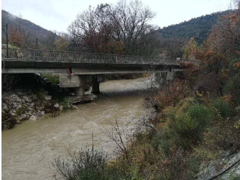
Figure 8 : Pont de la Roche (D13)
