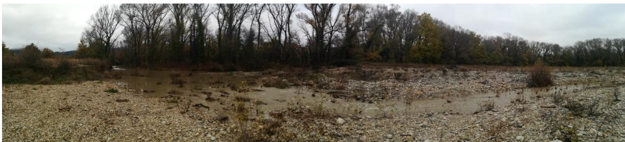
Figure 18 : Entrée du méandre coupée par la crue de 2019
