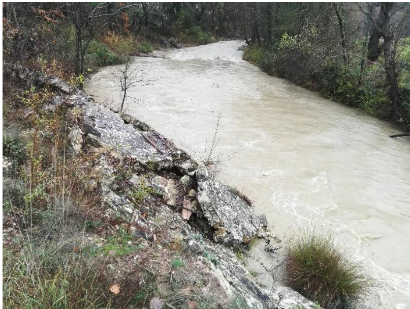
Figure 9 : Protection de berge aval RG pont de la Roche
