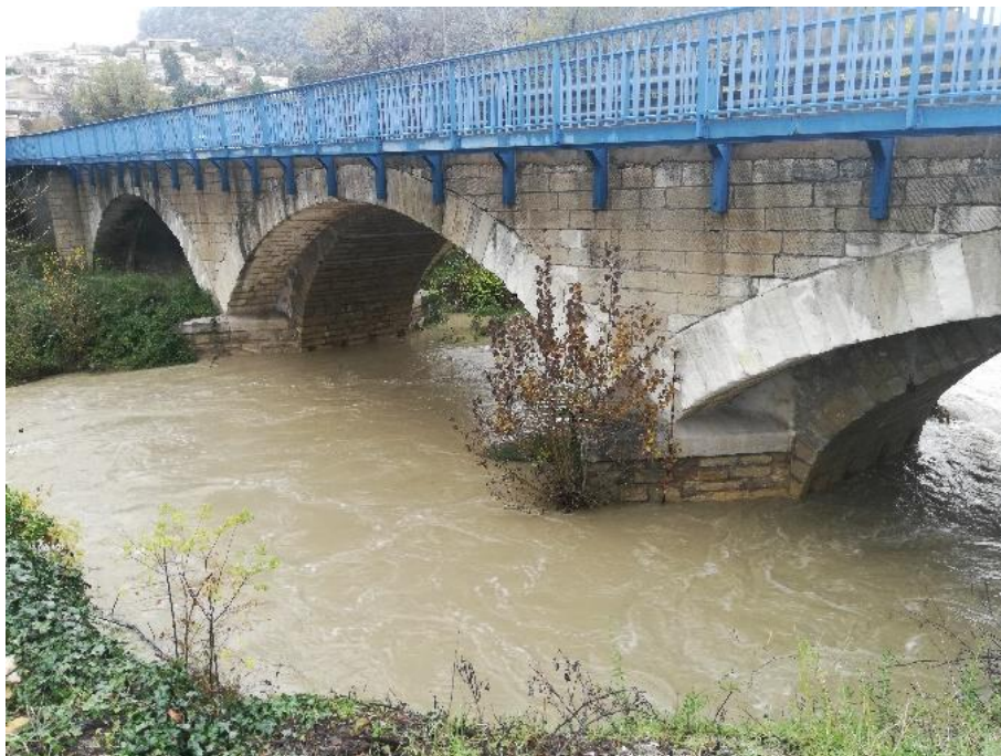
Figure 12 : Pont de la RD4096 et l'atterrissement à gauche de la photo
