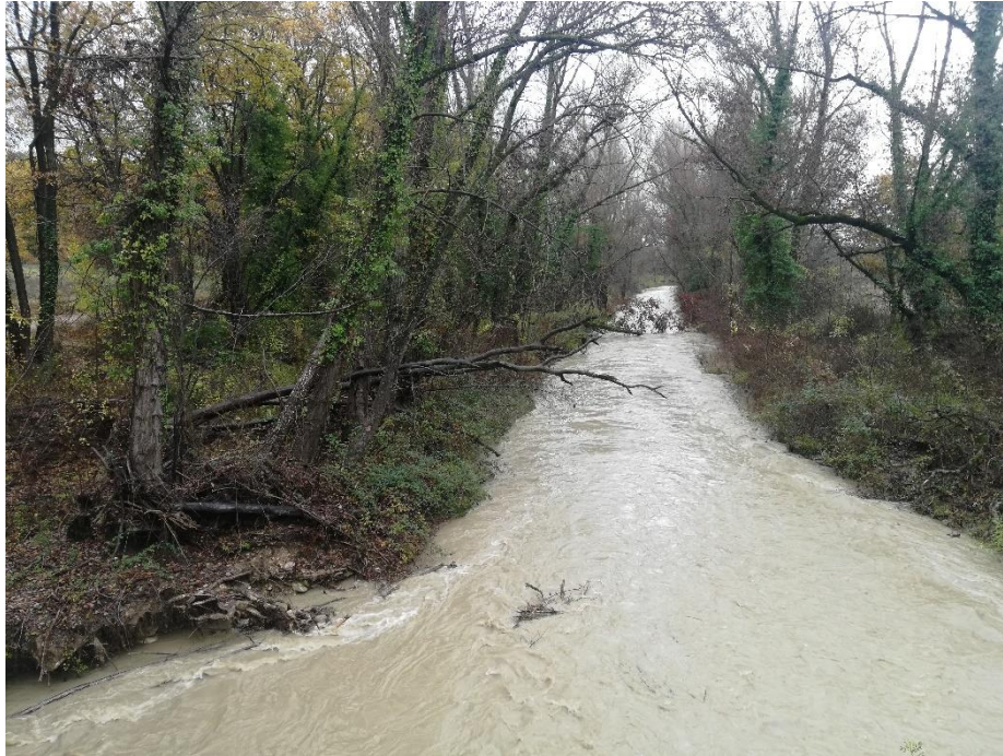
Figure 6 : Figure 5 : vue aval depuis la passerelle de la voie verte
