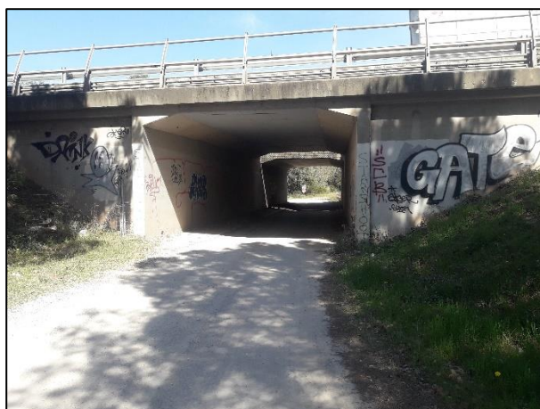
Pont cadre, zone de transit pour la faune terrestre
