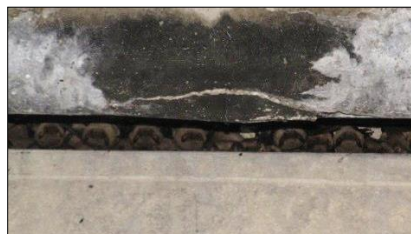
Colonie de Pipistrelle pygmée sous un pont
