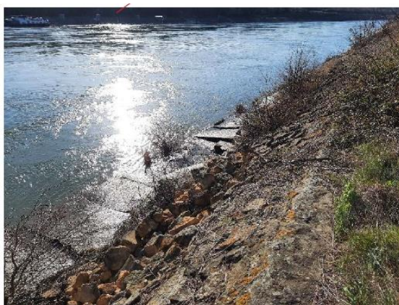
Figure 3 : Photographies des dalles dégradées en partie émergée (Source : CNR, Diagnostic des procédures janvier 2023)
