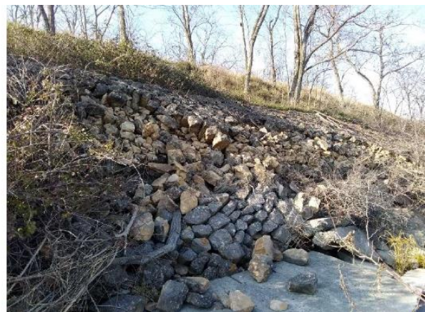
Figure 3 : Photographies des dalles dégradées en partie émergée (Source : CNR, Diagnostic des procédures janvier 2023)
