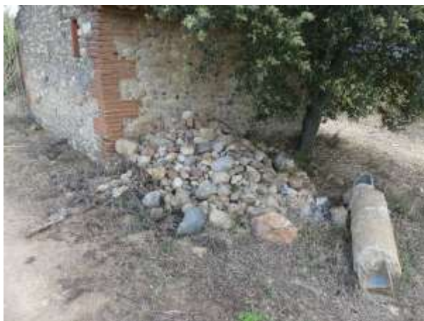
Tas de pierres aux abords du parc agrivoltaïque Emilie Levesque (ARTIFEX), 18-06-2021
