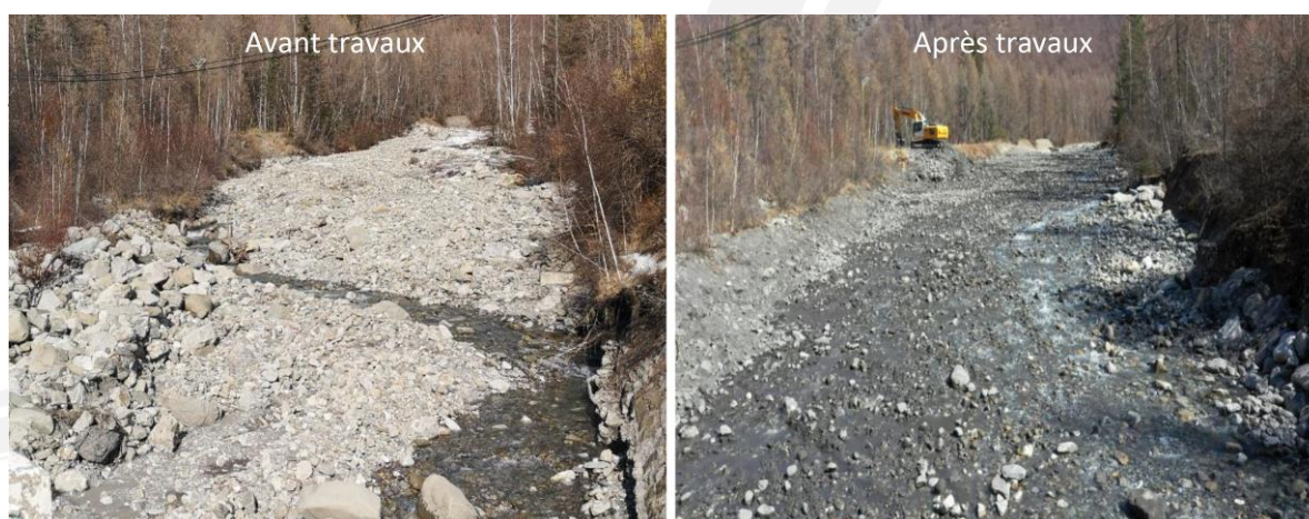
Figure 16 : Travaux de restauration du profil objectif du torrent de Méollion (2021)
