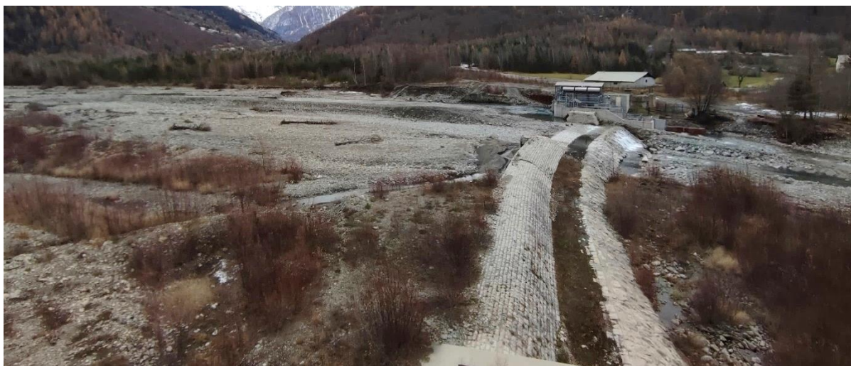
Figure 10 : Seuil des Ricous et prise d'eau de l'ASA du canal de Gap (2022)
