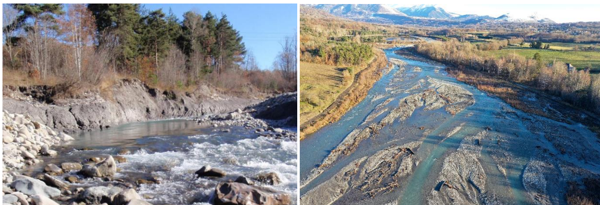
Figure 17 : Travaux de restauration/recharge du Drac entre St-Julien et St-Bonnet-en-Champsaur (2014)
