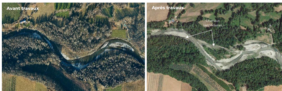
Figure 20 : Défrichage et restauration de chenaux secondaires sur le Drac à St-Julien en Champsaur (2022)
