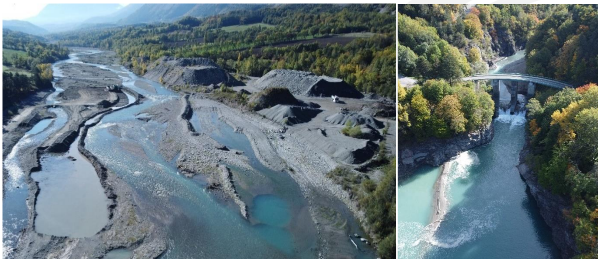
Figure 11: Site d'extraction du Motty à gauche et pont du Loup à droite (2022)
