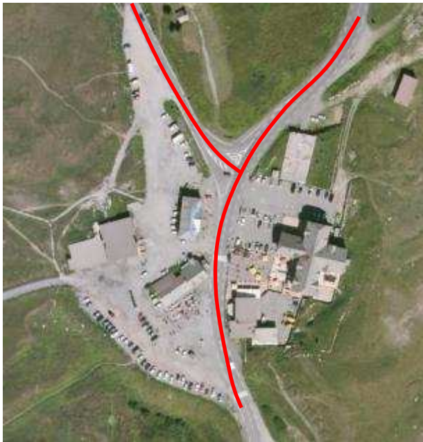
Zones de chaussée rénovées dans le cadre des travaux (type SCINTIFLEX)
