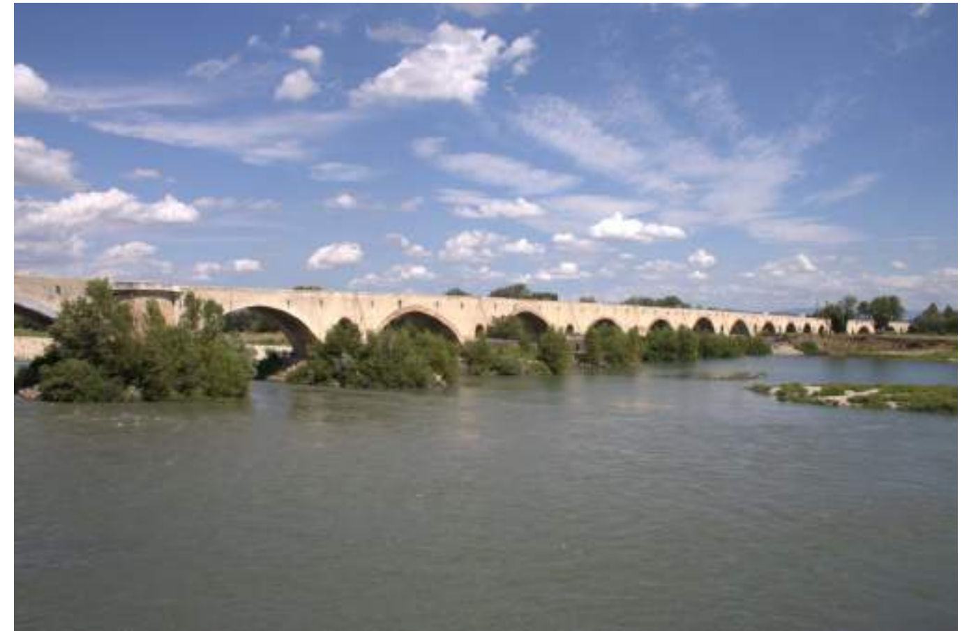
Photo 4. Pont Saint Esprit, source : © Wikipédia
