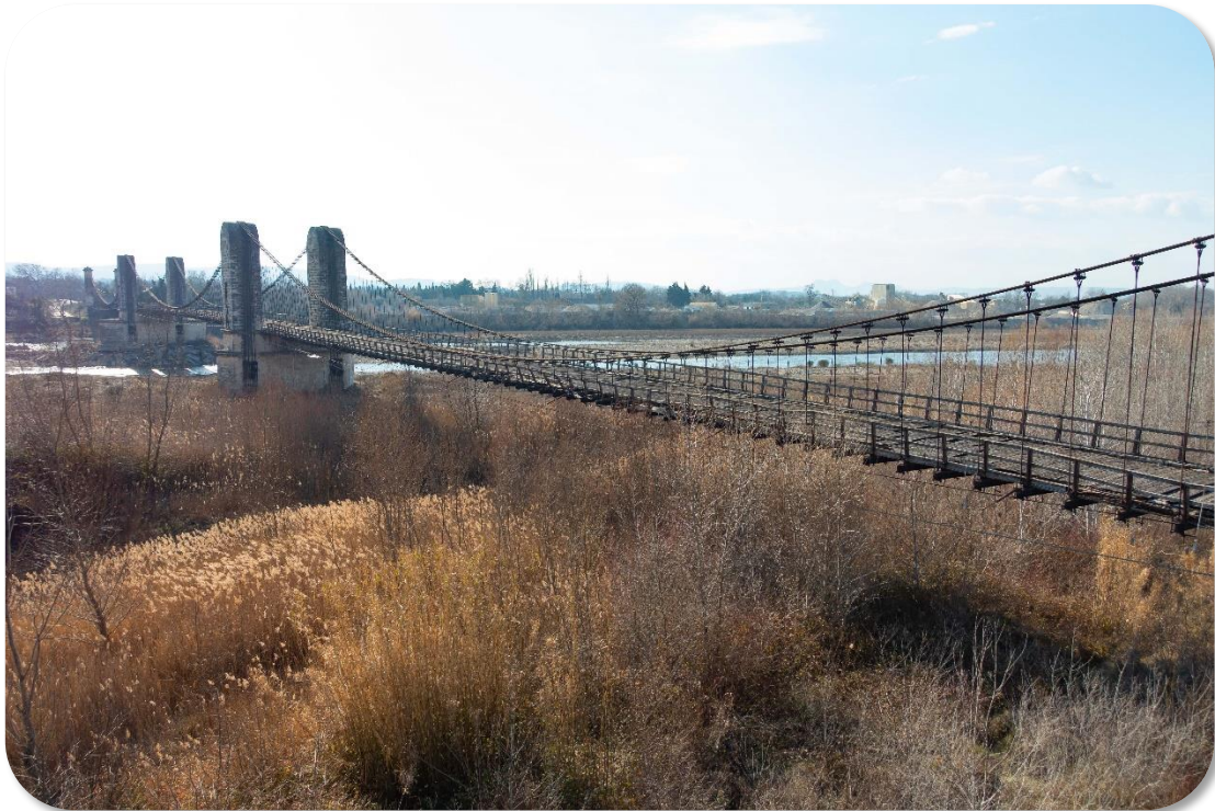
Photo 5 : Ancien pont suspendu franchissant la Durance
