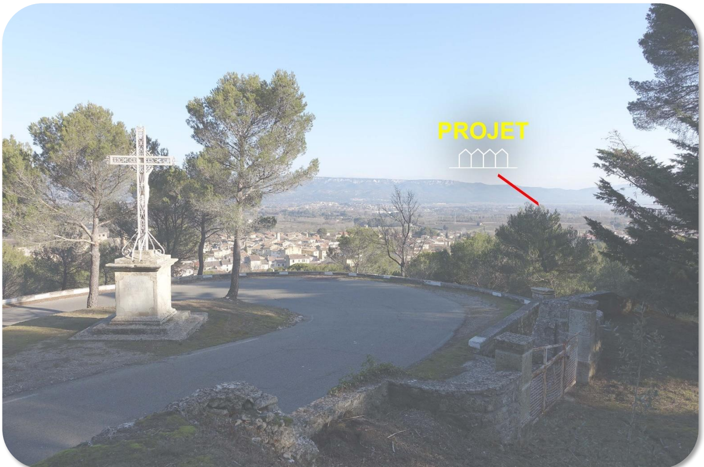
Photo 38 : Vue en direction du site du projet depuis le site du calvaire d'Alleins
