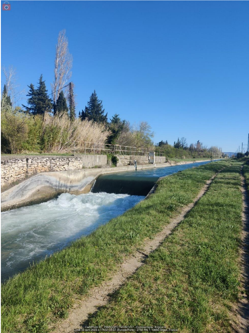
Photo 3 : Chute et site vue vers l'amont rive gauche
