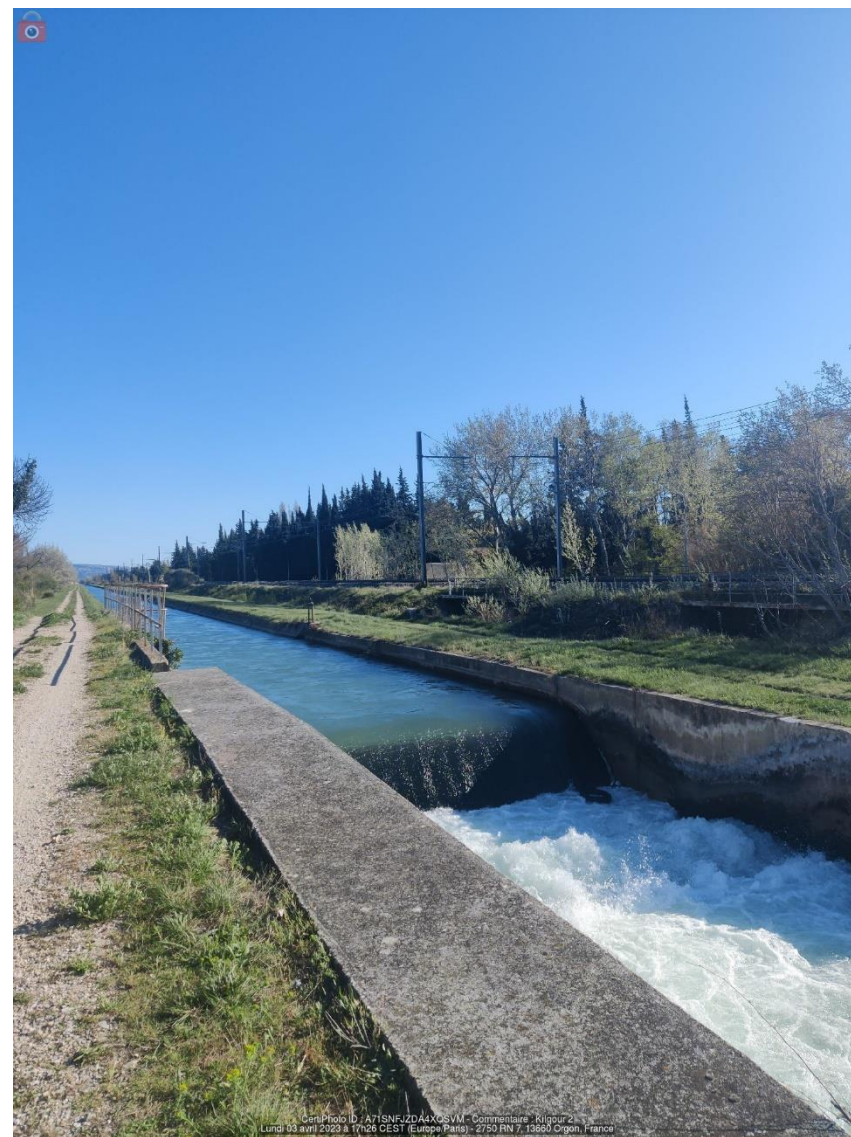
Photo 2 : Chute et site vue vers l'amont rive droite
