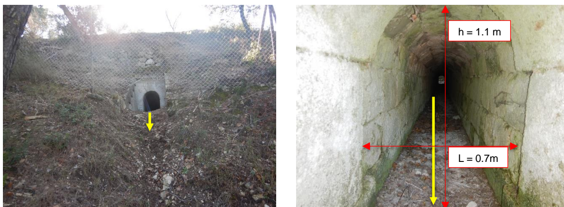
Figure 9 -Vue de la face aval de l'ouvrage de transparence hydraulique depuis la parcelle de projet
