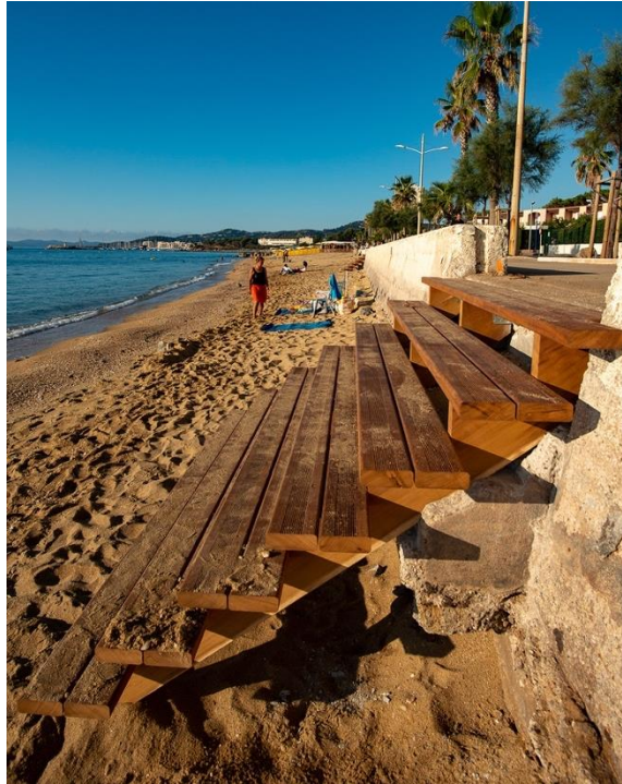
Figure 46 : escalier en bois installé sur le tronçon en érosion
