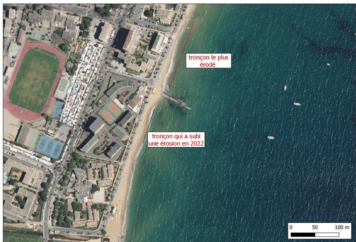
Figure 81. Tronçons ayant subi une érosion en 2022
