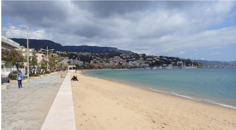
Figure 7 : Linéaire le plus touché par le phénomène d'érosion après la pose de big-bags (ICTP – avril 2021)
