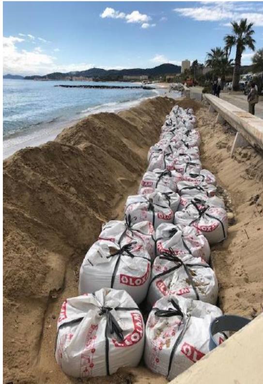
Figure 32 : Mise en place des big-bags le long du mur de soutènement – (Photographie extraite du reportage photo)
