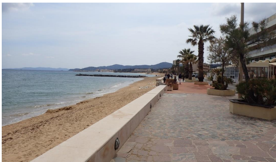
Figure 3 : Avenue du Général Georges Bouvet le long de la plage du Centre-Ville (ICTP – avril 2021)
