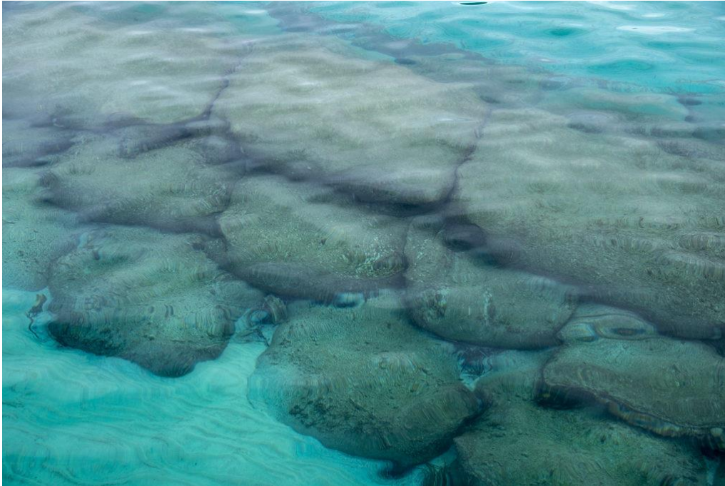
Figure 89 : Exemple – Photographie d'un brise lame composé de sacs en géotextiles sur la plage de la Cavalière – Mairie du Lavandou
