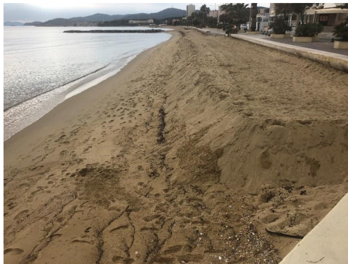
Figure 33 : Création d'une dune au-dessus des big-bags (photographie extraite du reportage photo)
