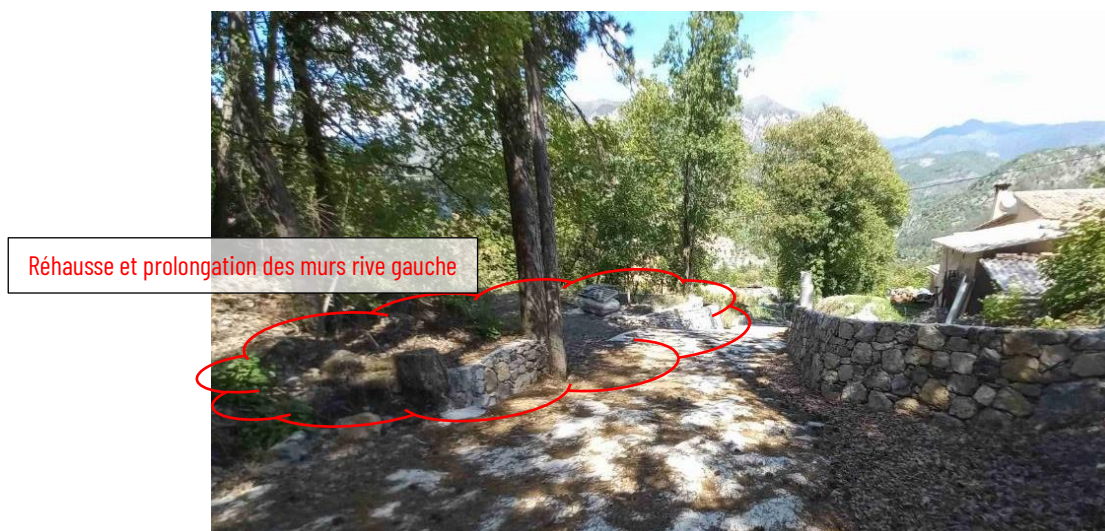
Figure 12 : Vue du chenal-route depuis l'amont
