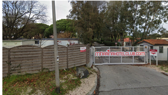
Entrée du site - Avant
