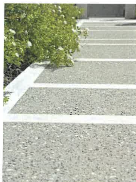
Voirie principale Béton désactivé
