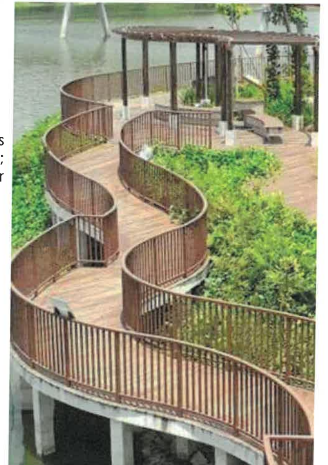
Système de passerelle sur pilotis pour rejoindre les entrées des immeubles et garantir la transparence hydraulique
