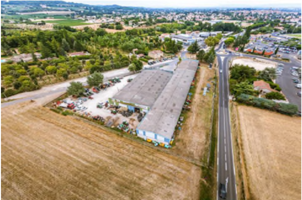
Illustration 8 : Vue sur la zone du projet – direction sud-ouest (source : Arck'In'Tech)
