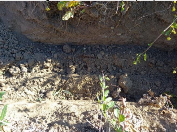
Sondage à la pelle mécanique (PM7)
