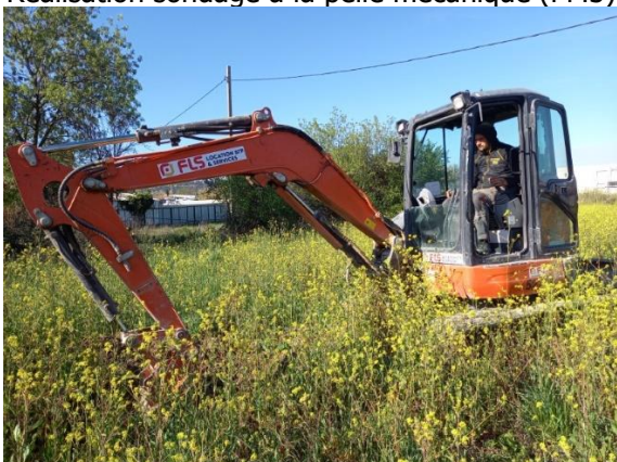
Réalisation sondage à la pelle mécanique (PM4)
