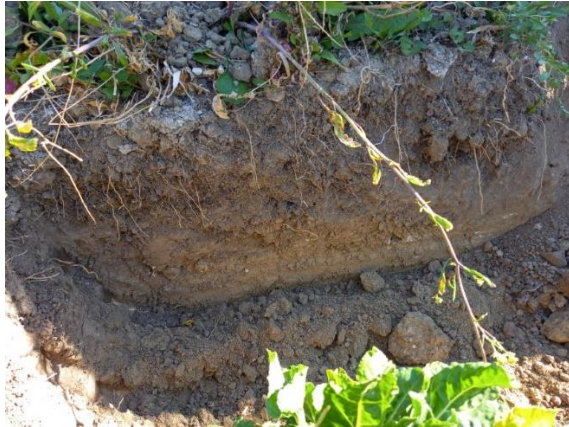
Sondage à la pelle mécanique (PM9)
