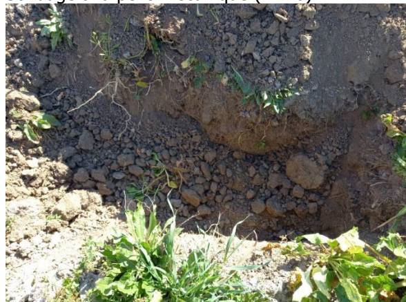
Sondage à la pelle mécanique (PM11)
