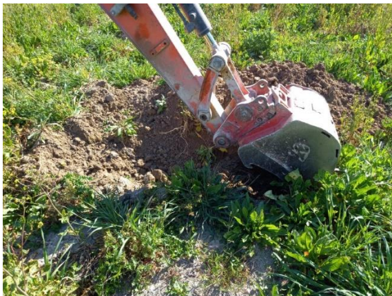
Réalisation sondage à la pelle mécanique (PM11)
