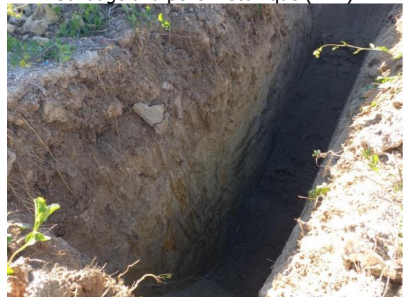
Sondage à la pelle mécanique (PM2)
