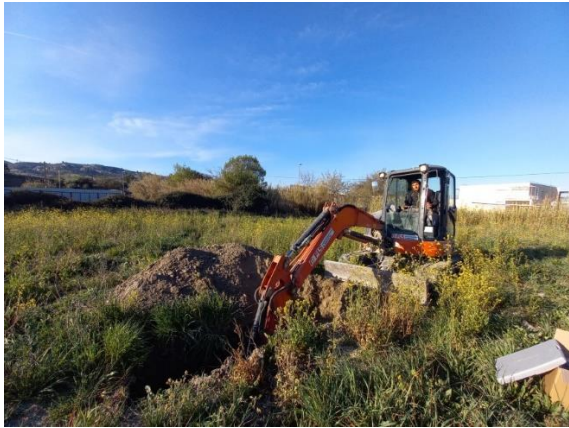
Réalisation sondage à la pelle mécanique (PM1)
