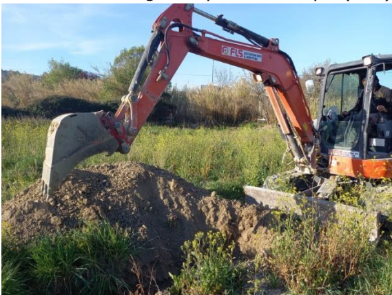
Réalisation sondage à la pelle mécanique (PM2)
