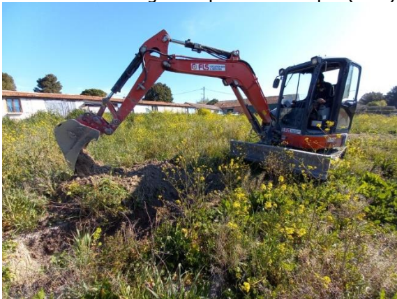
Réalisation sondage à la pelle mécanique (PM6)
