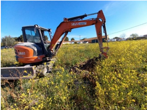
Réalisation sondage à la pelle mécanique (PM7)
