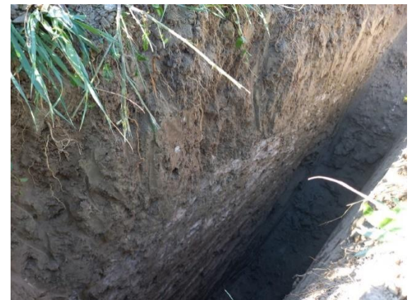
Sondage à la pelle mécanique (PM3)
