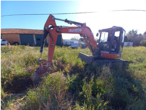
Réalisation sondage à la pelle mécanique (PM5)
