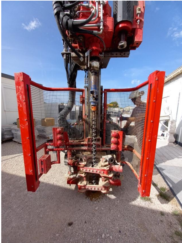
Sondage à la tarière mécanique (ST5)
