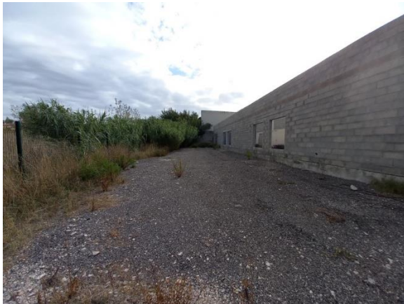
Extension à l'arrière du bâtiment actuel
