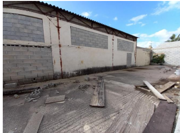
Extension à l'arrière du bâtiment actuel
