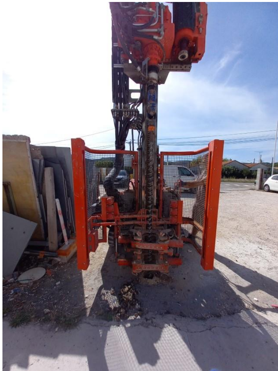
Sondage à la tarière mécanique (ST7)
