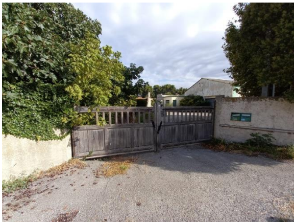
Portail d'entrée de l'ancienne menuiserie
