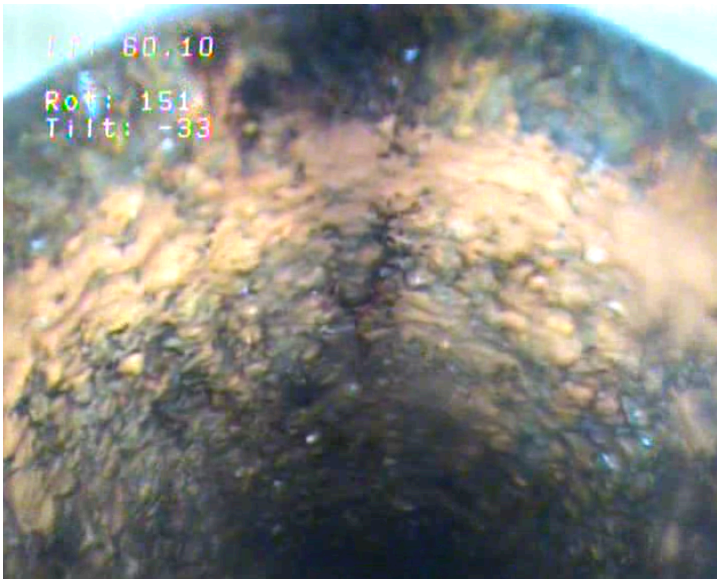
Profondeur 60,10 mètres. Dépôt sur tubage important.
